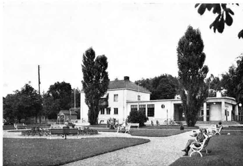
Järnvägsstationen. The Railway Station.
