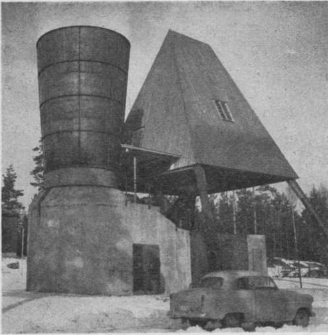
Fig. 4. Fläkthus och lave vid ventilationsschaktet.
