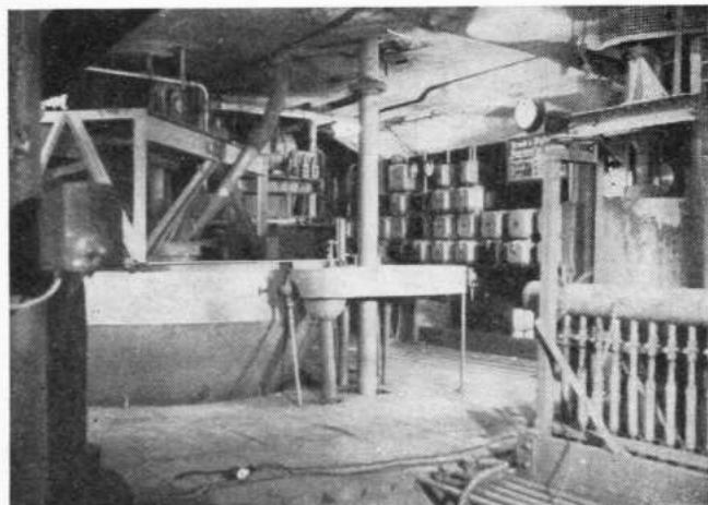
Fig. 4. Interiör från Stripa-anläggningen; i förgrunden t.v. kon, i bakgrunden t.h. kopplingspanel för elutrustning till alla maskiner i anläggningen.
