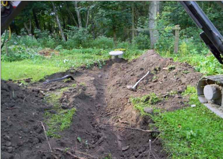
Figur 4. Den arkeologiska arbetet inleddes med att schakta fram den befintliga avloppsledningen. Bilden är tagen från norr. Foto: Ingeborg Svensson 2012, Sörmlands museum.
