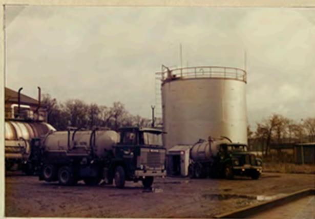
Sanering av gamla oljetanken. (skall användas till lagertank för mycel )
