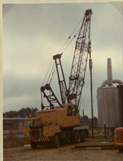
Pålning med 9meter lång järnräls. ( ner i marken ca.8meter ) För betong- plattan till Biofilter syst. Kneer.
