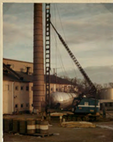
Pålning för betongplattan till nya oljetankarna.
