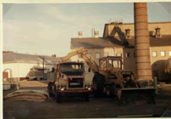
Schaktning för betongplattan till nya oljetankarna.
