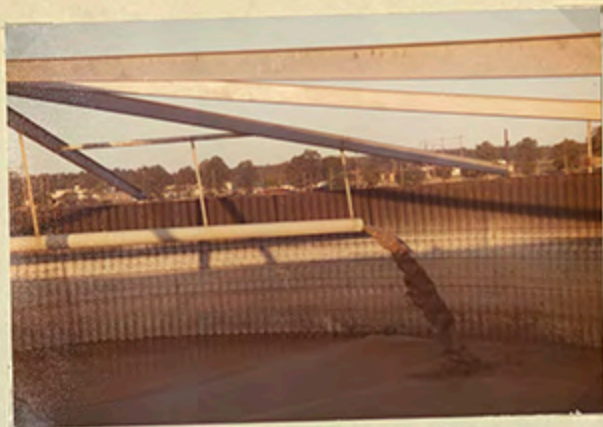
Utpumpning av slam från förtjockare till plåtsilon. ( Lagersilo för reningsverksslam ) 75.09.22.
