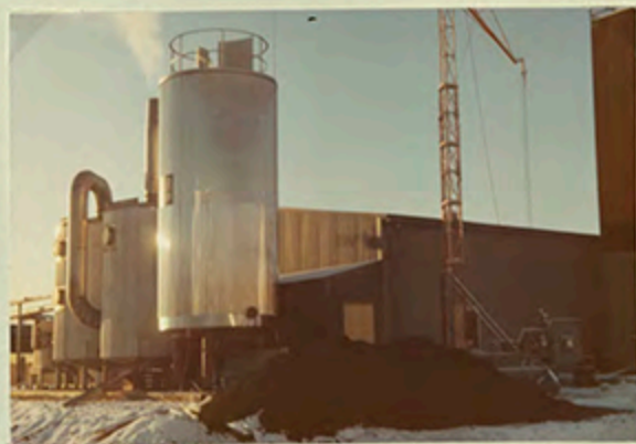
Byte av jord i biofiltret. 75. 12. 17.
