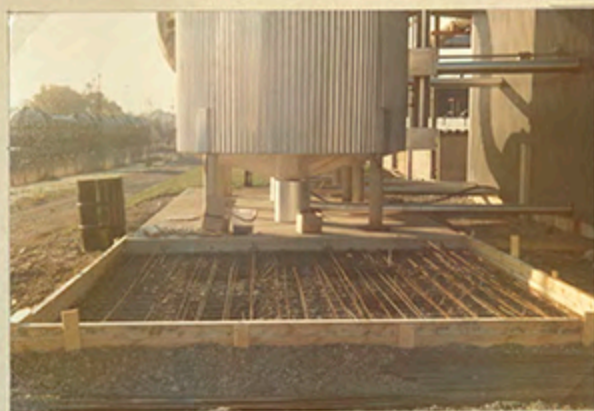
Formsättning och armering för betongplattan. 75.10.20.
