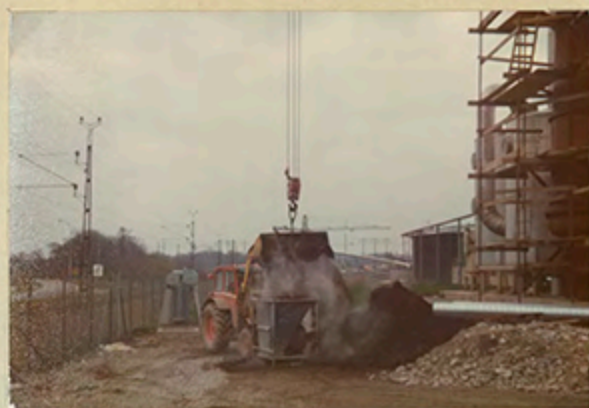
Reaktorn fylls med kompostjord(ca 16m 3 )
