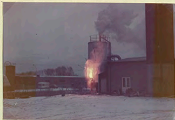
Brand i biofiltret efter svetsningsarbete. (byte av rör muffar för provtagning av biomassan) 76.12.13.
