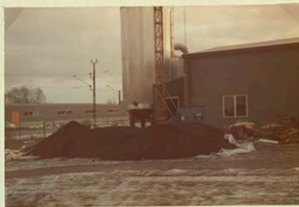
Återfyllnad av ca. 20m 3 jord.
