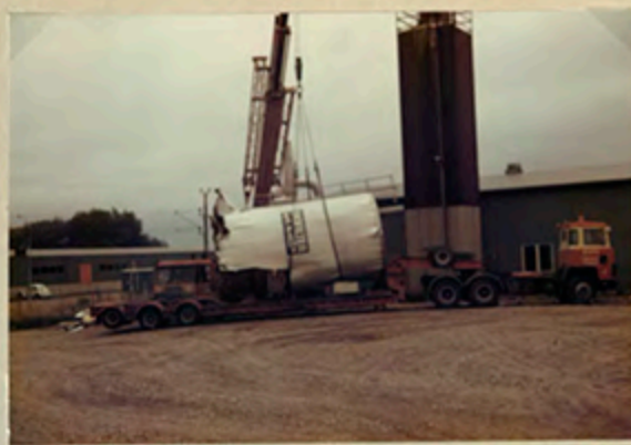
Lastning och borttransport av filtret biofiltrets epok vid Fermenta är slut. 77. 08. 10.
