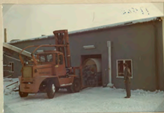
Flyttning av vakuumfiltret från reningsverket till jöshallen. 77. 02.11.
