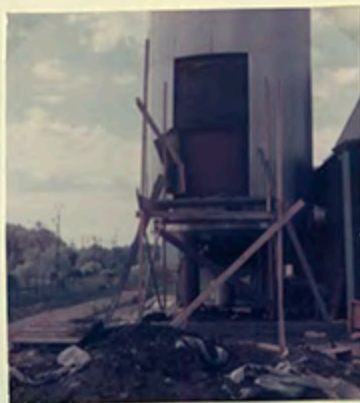
Biofiltret tömdes i sin helhet, p.g.a. haveri med skruven för utmatningen av jordmassan. 76. 06. 04.
