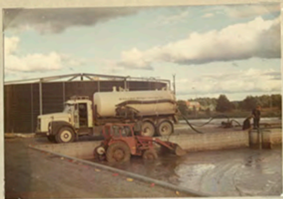
Också ett sätt att få gröten till pumpgropen. Lasse kör trakorn. 75.05.22.
