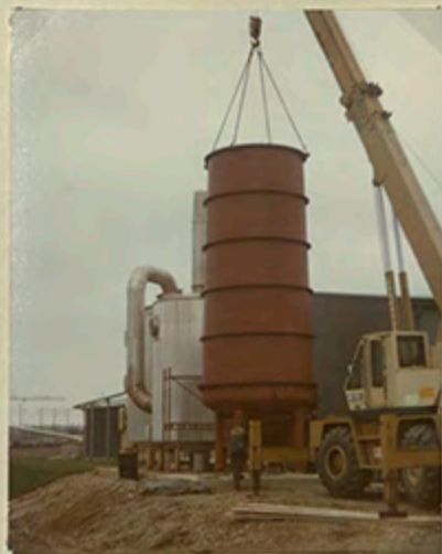
Reaktortanken an- länder och lyftes på plats. 75.10.24.
