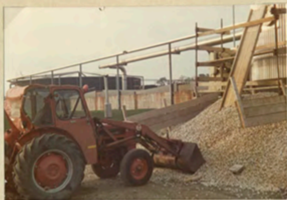
Fyllkropparna flyttas till ny uppläggnings- plats ( på gärdet ). 75.10.14.
