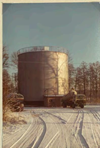
Fyllning av mycel i lagertanken(2000m 3 ).
