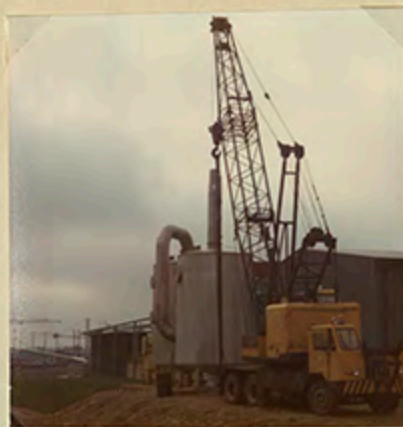
Pålning med 9meter lång järnräls. ( ner i marken ca.8meter ) För betong- plattan till Biofilter syst. Kneer.
