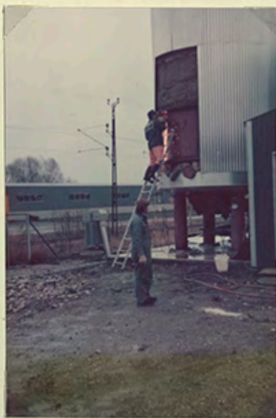
Höltagning i Biofiltret, byte av jord och borttagning av huv över utmatningskruv 76. 11. 04.
