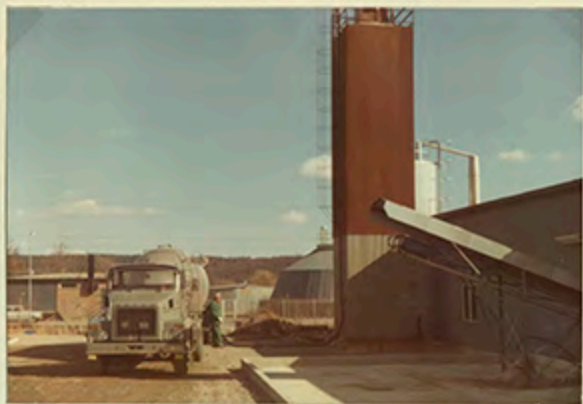
Fyllning av kalksilo.
