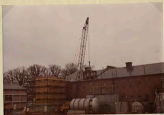
80m 3 jöstankarna lyfts in i jöshallen.
