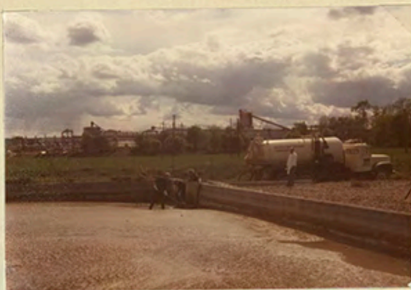
Tömmning av betongbassängen, var fylld med slam och mycel (sista utvägen att klara hösten och vintern 74). 75. 05.22.
