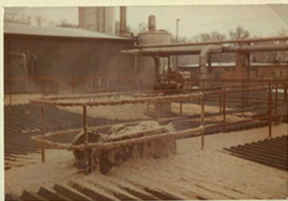
Luftningsbassängerna skummar över.
