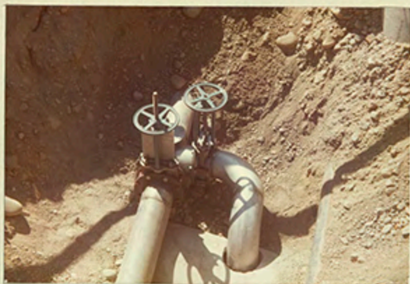
Rördragning och ventiler klart. utg avlopp nu till kylvattentuben.
