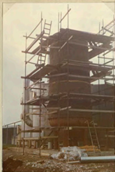
Isolering av reaktortanken. 75.11.18.
