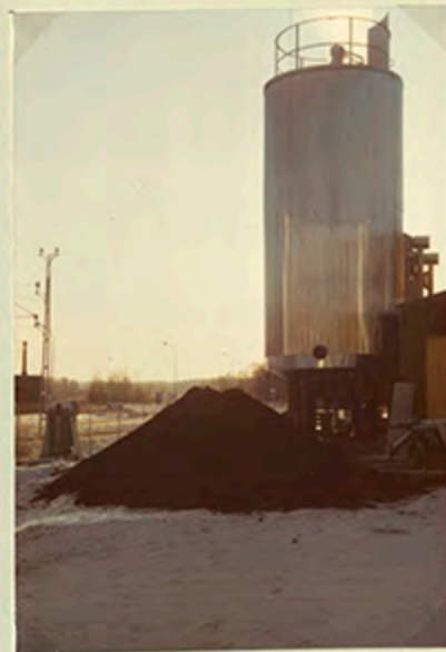
Byte av jord i biofiltret. 75. 12. 17.
