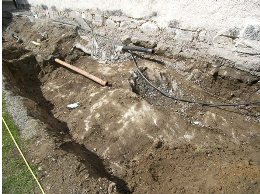
Figur 1. Schaktet (etapp 2) vid södra korsarmen där fast berg framkom vid cirka 0,5 meter under dagens markyta i den östra delen. Foto: Björn Pettersson, Sörmlands museum 2014.
