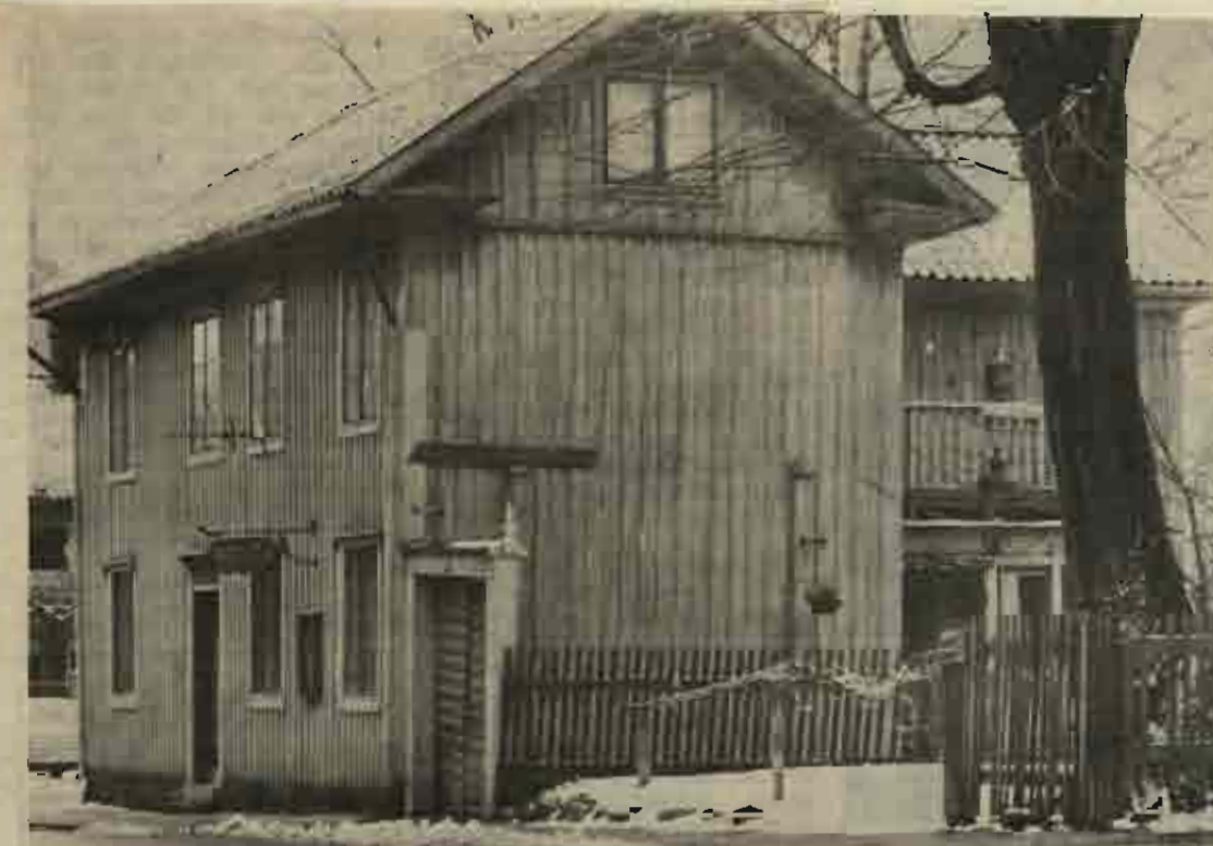
Det gamla huset, Brunnsgatan 54, skall rivas inom kort. Trafiken måste fram här. Huset är 1700-tal, men byggdes till på 1860-talet.
