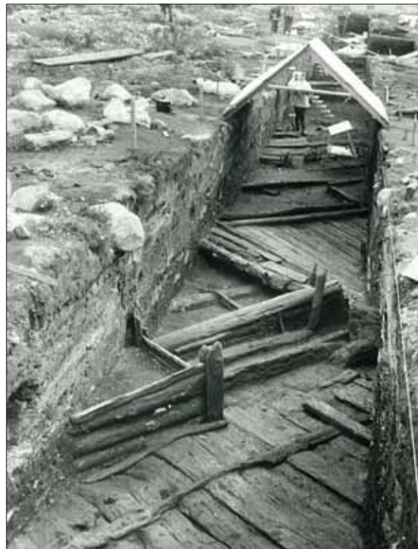
Figur 8. Kvarteret Rådhuset 1964. SR49a fotograferat mot sydost. I förgrunden syns bland annat välbevarade träkonstruktioner till en medeltida byggnad i skiftesverk och en kavelbro. SMA, K7:1.
