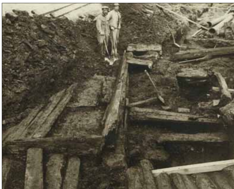
Figur 4. Västra Kvarngatan och Rådhusgränd (kvarteret Åkroken) 1924-25. Fotografiet togs i samband med att man grävde ned vatten- och avloppsledningarna i Nyköping. På bilden syns rester av en husgrund med plankgolv, samt i förgrunden en kavelbro. SMA, K7:1.
