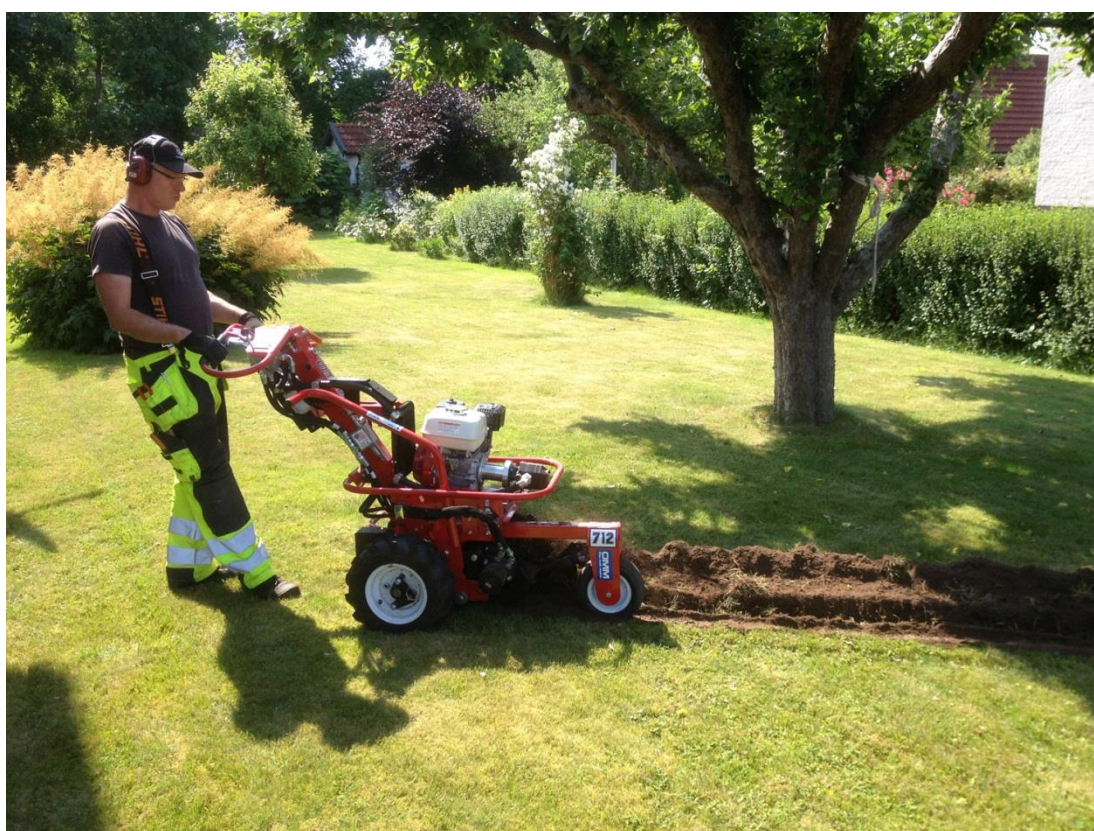
Figur 8 Fräsning i trädgård, Slottsvägen fastigheten Stigbygeln 12
