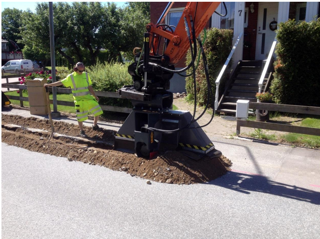
Figur 6 Fräsning i gatumark, Cedergrensvägen övre delen
