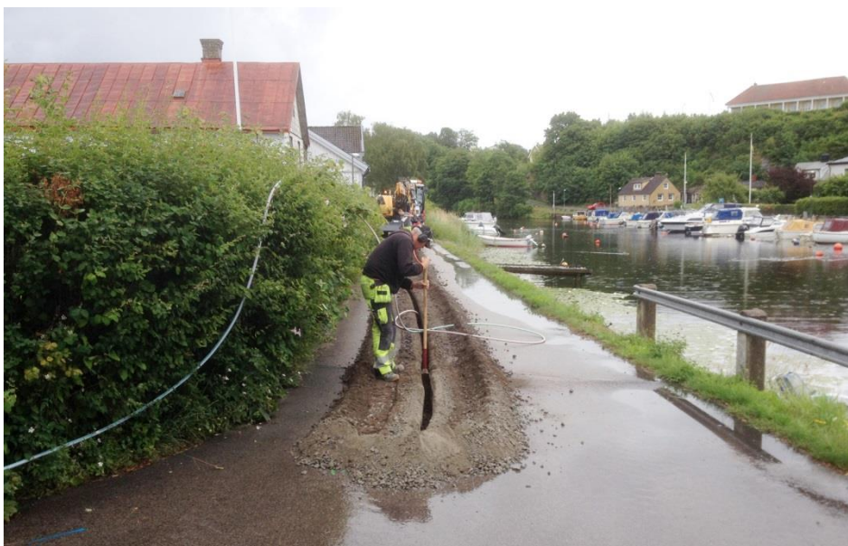
Figur 112 Fräsning i Nedre Lyckåvägen, längs med Lyckebyån
