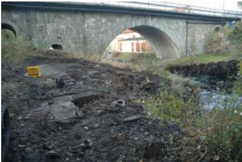
Figur 6. Schakt 1 sett från norr.
