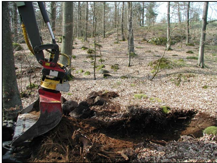
Fig.4 Schakt 10, fotograferat mot väster.
