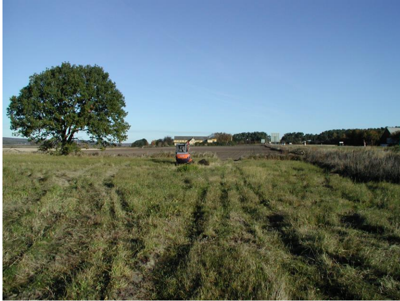
Fig.3 – Överblick mot norr, schaktning parallellt med väg E22.
