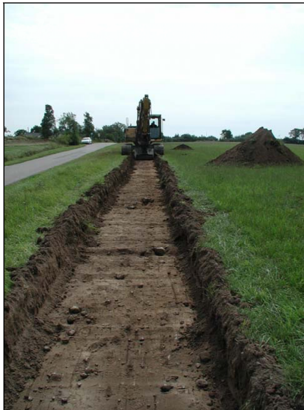
Fig.2 – Överblicksbild av schaktning, fotografi taget i SO riktning.
