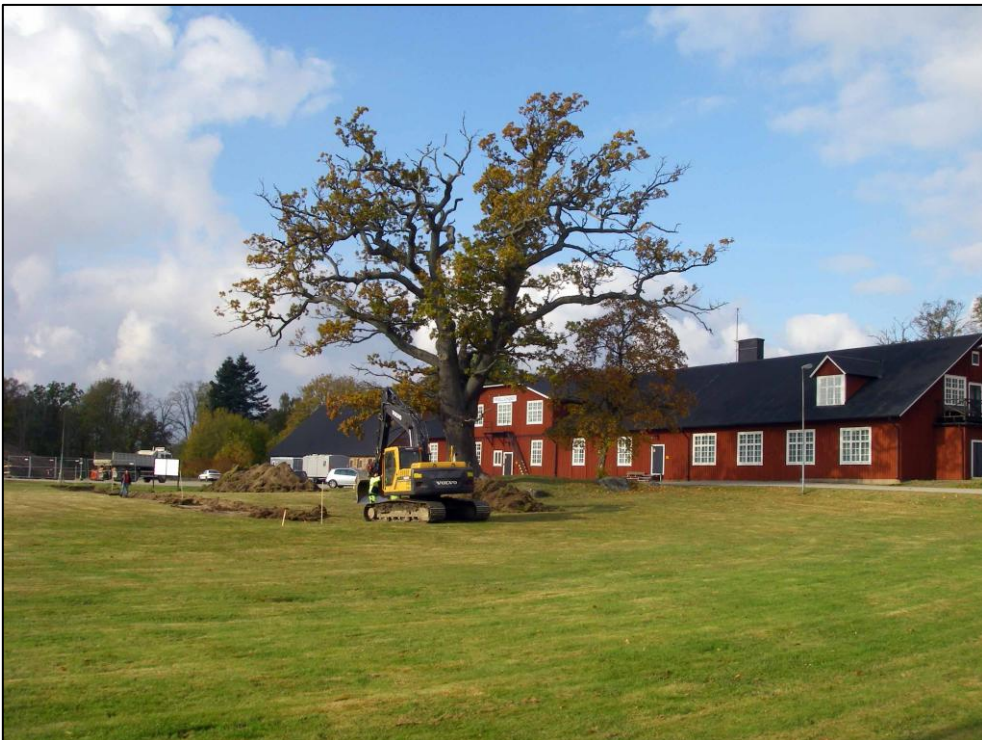
Schaktning inom Delområde 3 mot NV.
