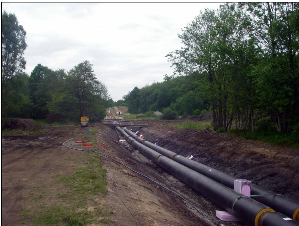
Ledningsschakt inom Delområde 2 mot N.
