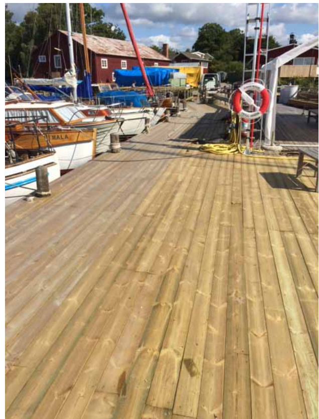
Stora bryggan reparerades..
