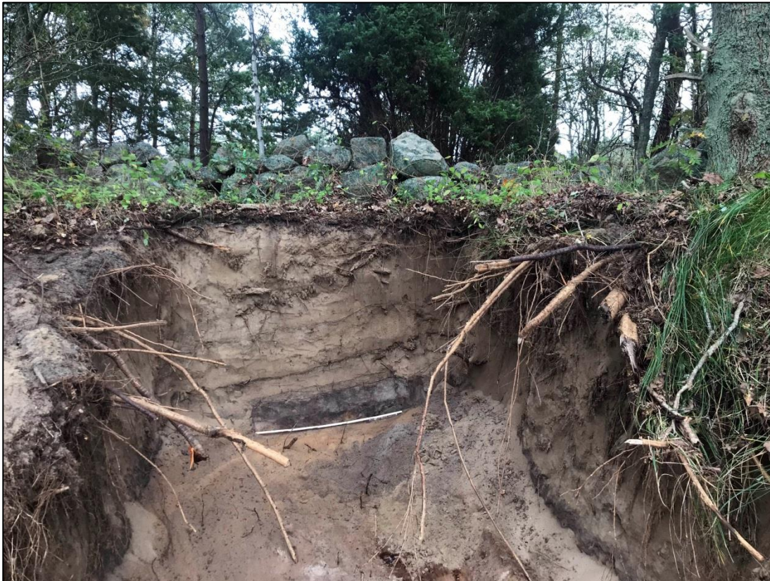
Fig.4 – Framrensad sektion mot stenmur och sanddyn i öster.
