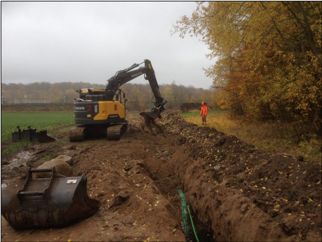
Fig.3 – Besiktning av schakt vid Torsfors, fastigheten Augerums Ryd 1:16 2020-10-28.
