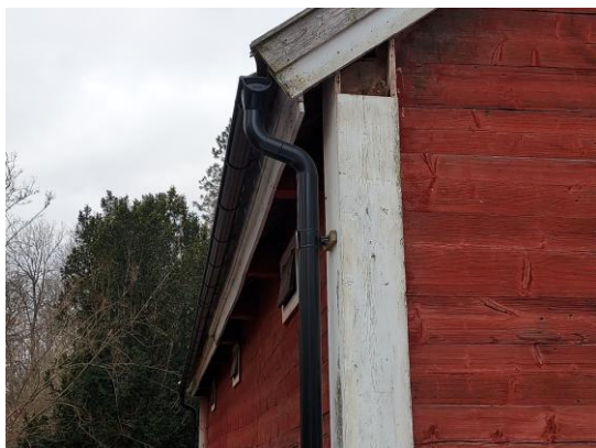
Fig. 7. Saknad täckbit på knutbräda.
