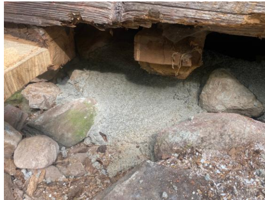
Fig. 19 (t.v.). Borttagen syllbit. Bärande bjälke till innervägg synlig. Fig. 20 (t.h.). Den väggbärande bjälken fixerad med underliggande betonggjutning och tappades hjälpligt in i ny syll. Stenar är lagda som isolering mellan betong och timmer.
