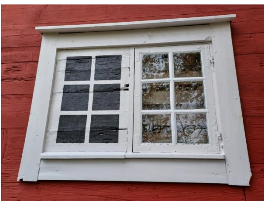
Fig. 9 (t.v.). Södra fasadens blinderingsfönster, innan arbetet. Fig. 10 (t.h.). Norra fasadens blinderingsfönster, efter arbetet. Notera utbytt del på vattbrädan.
