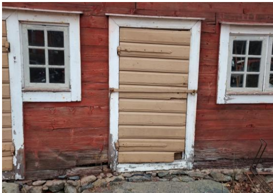
Fig. 3. Södra fasaden innan arbetet.
