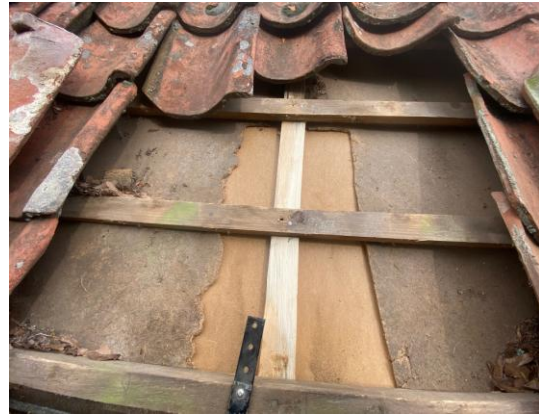
Fig. 16. Olfemasonit och ny ströläkt.
