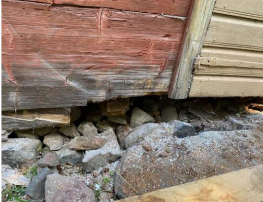
Fig. 19 (t.v.). Borttagen syllbit. Bärande bjälke till innervägg synlig. Fig. 20 (t.h.). Den väggbärande bjälken fixerad med underliggande betonggjutning och tappades hjälpligt in i ny syll. Stenar är lagda som isolering mellan betong och timmer.
