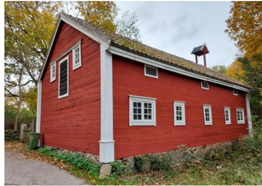
Fig. 2. Norra fasaden efter arbetet.
