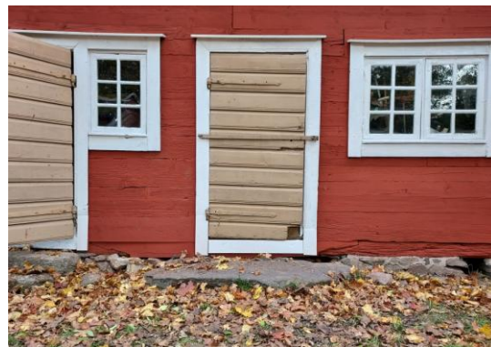
Fig. 4. Södra fasaden efter arbetet.
