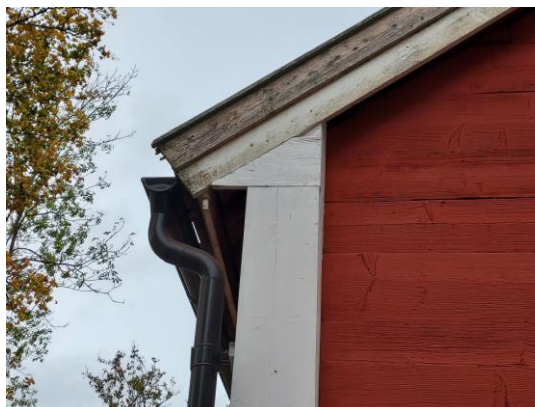
Fig. 8. Den saknade täckbiten återmonterad.
