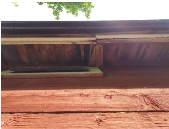
Fig. 12. Rötskadad takfotstass.
