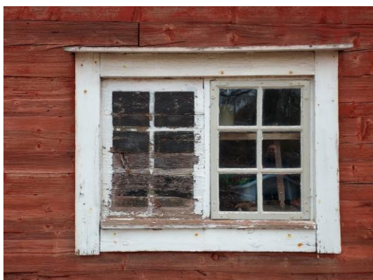
Fig. 9 (t.v.). Södra fasadens blinderingsfönster, innan arbetet. Fig. 10 (t.h.). Norra fasadens blinderingsfönster, efter arbetet. Notera utbytt del på vattbrädan.
