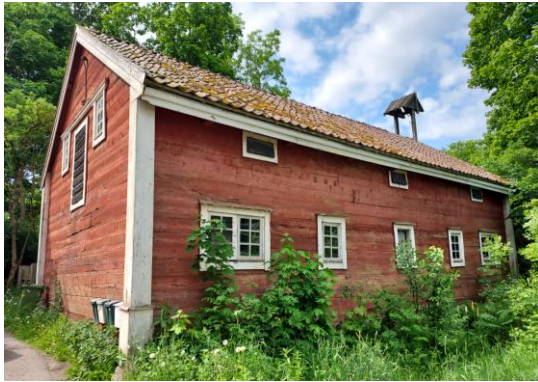
Fig. 1. Norra fasaden innan arbetet.
