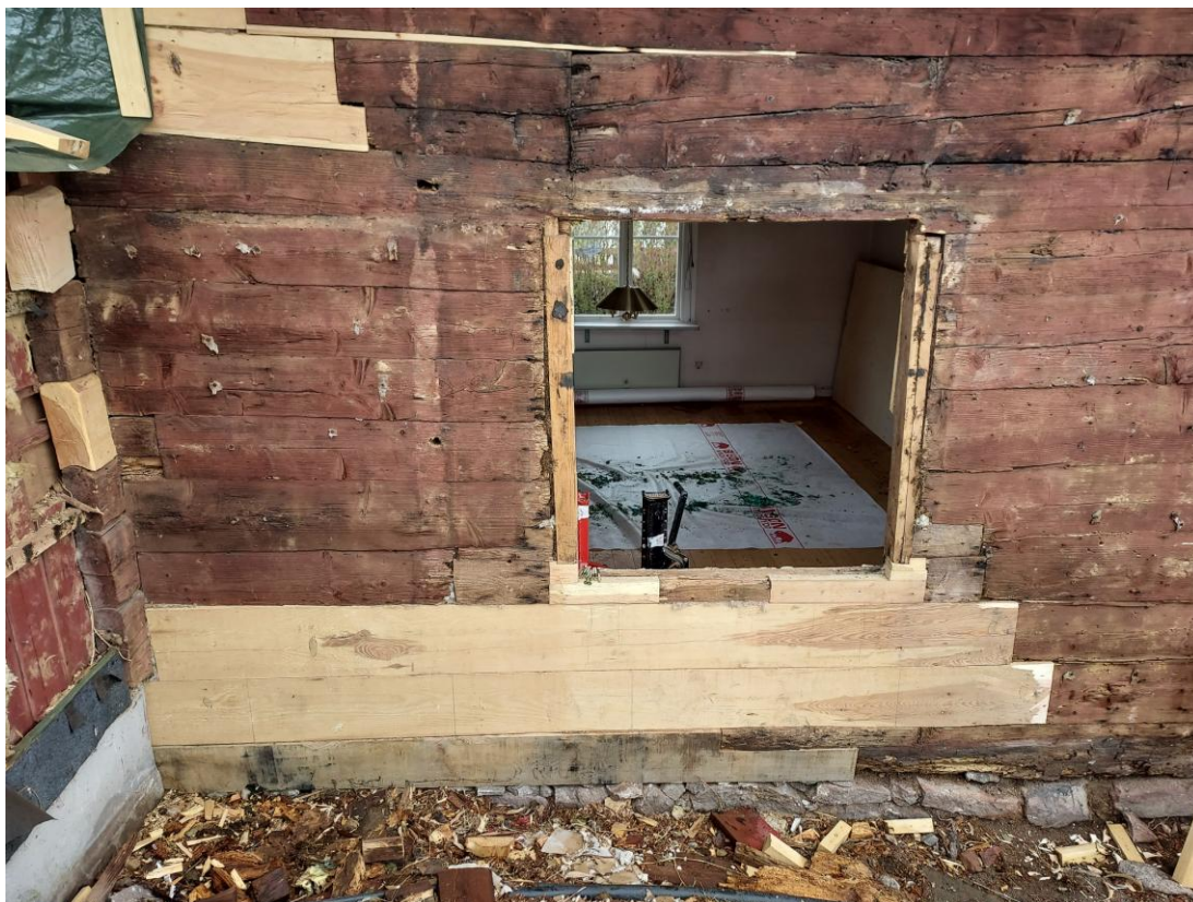
Fig. 4. Arbetsbild, södra fasaden. Jämför med fig. 3.
