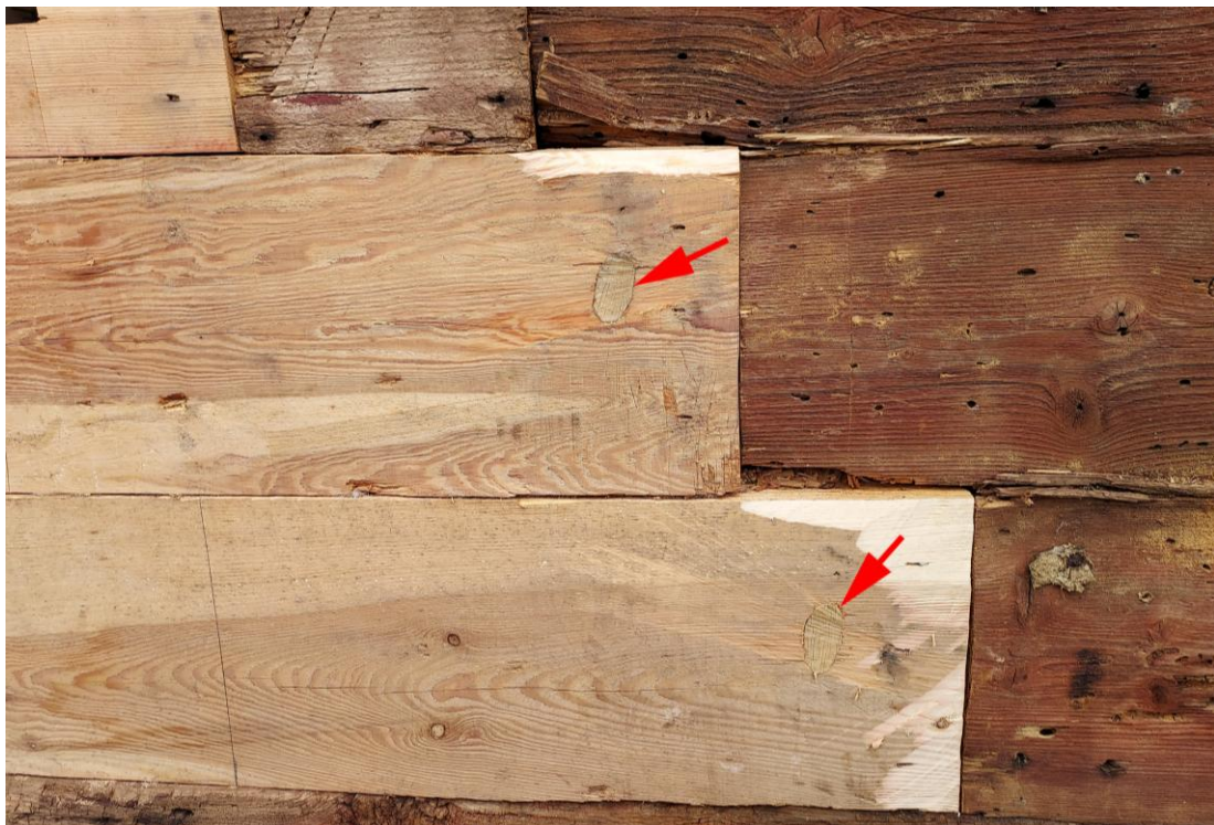
Fig. 21. Skrådubbning av infällt timmer, södra fasaden (under fönstret).
