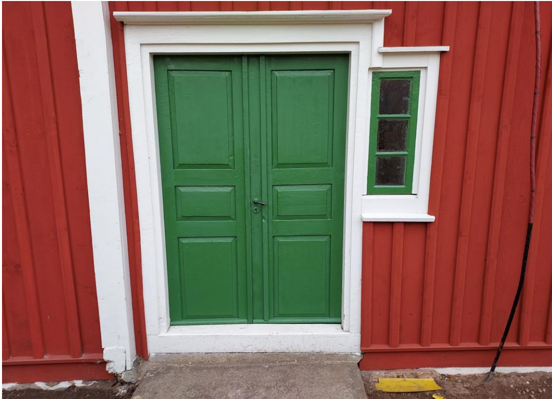
Fig. 7. Den norra ytterdörren med tillhörande sidofönster, efter arbetet.
