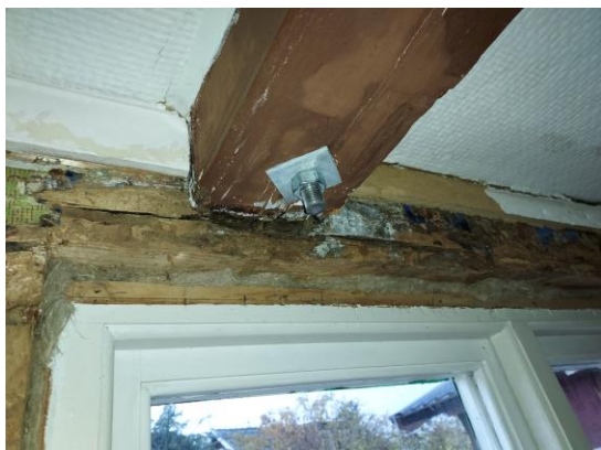
Fig. 13. Detalj, uppfästning av bindbjälke.
