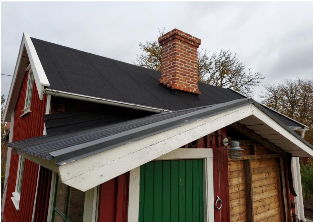
Fig. 24. Vy mot södra takfallet, efter arbetet. Den södra tillbyggnaden kommer att byggas om.
