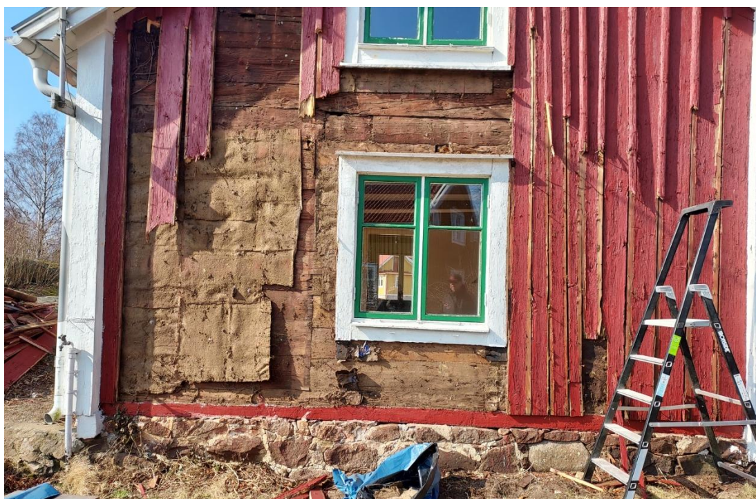
Fig. 9. Borttagning av panel från östra gaveln. Notera den ålderdomliga vindpappen.
