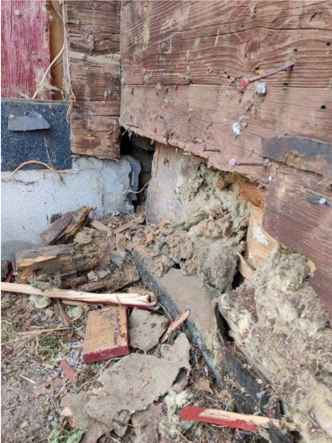
Fig. 3. Södra fasaden, rensning av rötskadat timmer. Foto David Carlsson.
