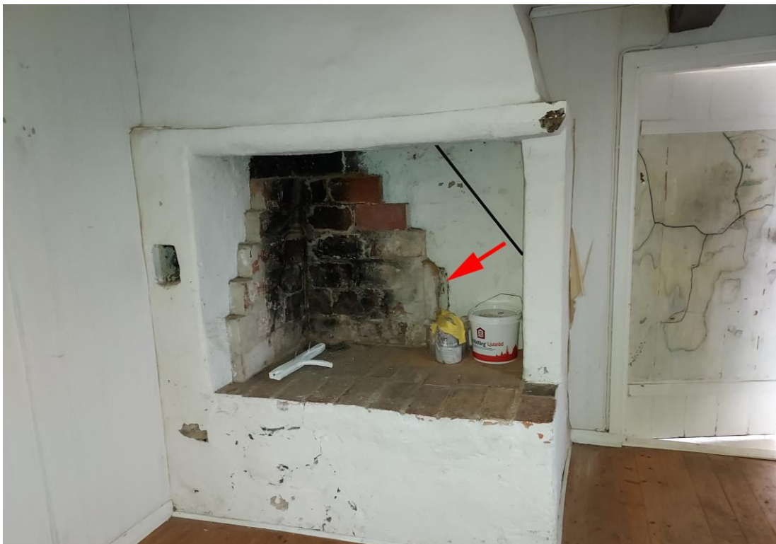
Fig. 29. Eldstaden. Röd pil markerar järnluckan till bakugnen, som kan skönjas bakom det sentida uppmurade flammskyddet av tegelstenar.
