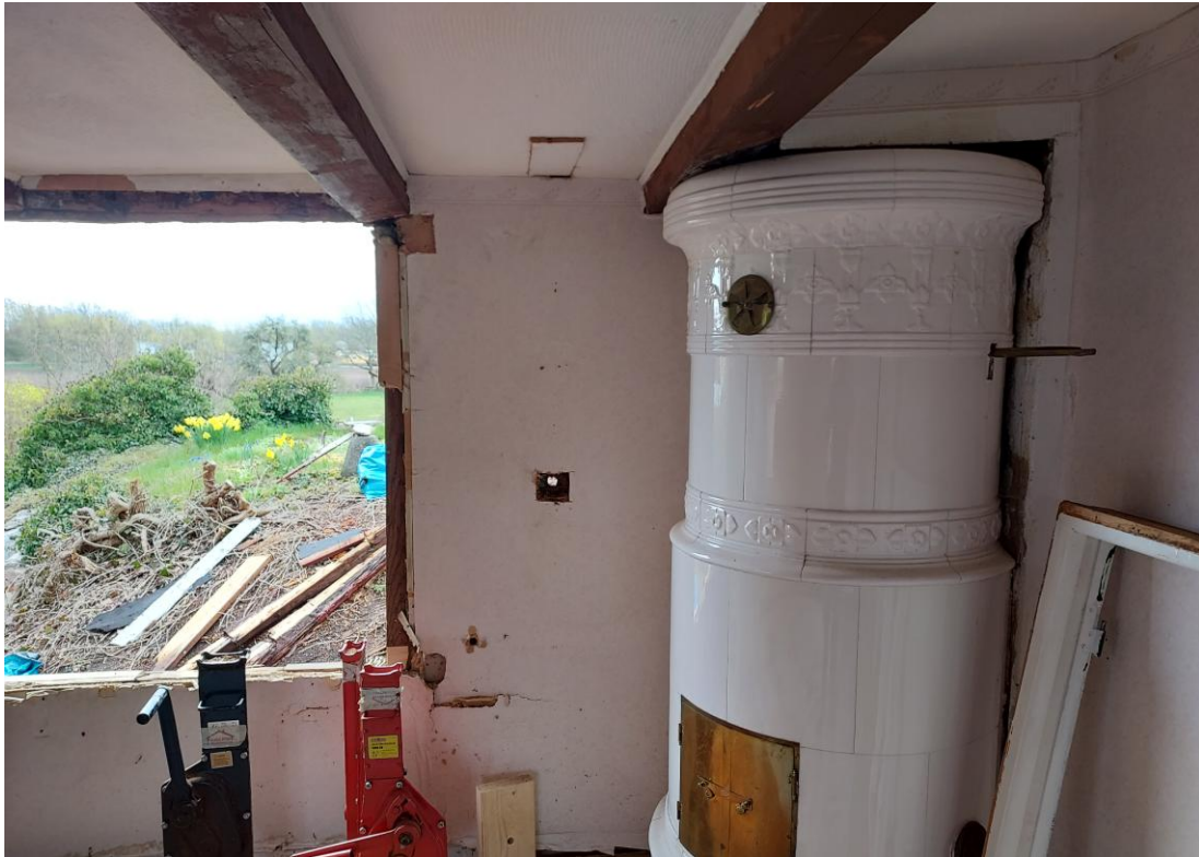
Fig. 28. Bindbjälkarna innan inspänningen mot ny ryttarbjälke. Notera hur den högra bindbjälken vilar på kakelugnen!
