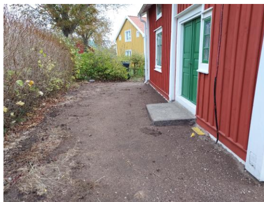
Fig. 6. Norra fasaden, efter marknivellering.
