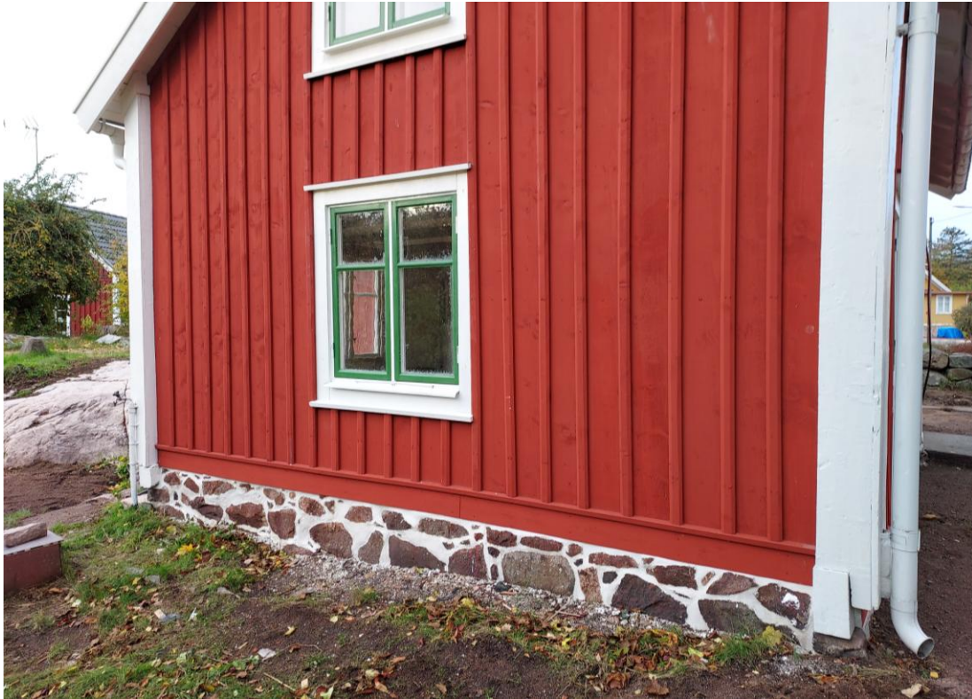
Fig. 23. Östra gaveln, efter arbetet.
