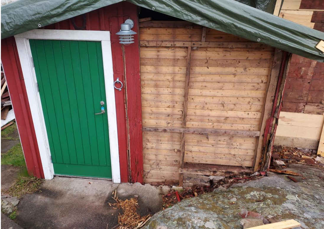
Fig. 19. Tillbyggnaden, efter att panelen börjat demonteras. Notera den klena konstruktionen och anslutningen mot berghällen/marken.
