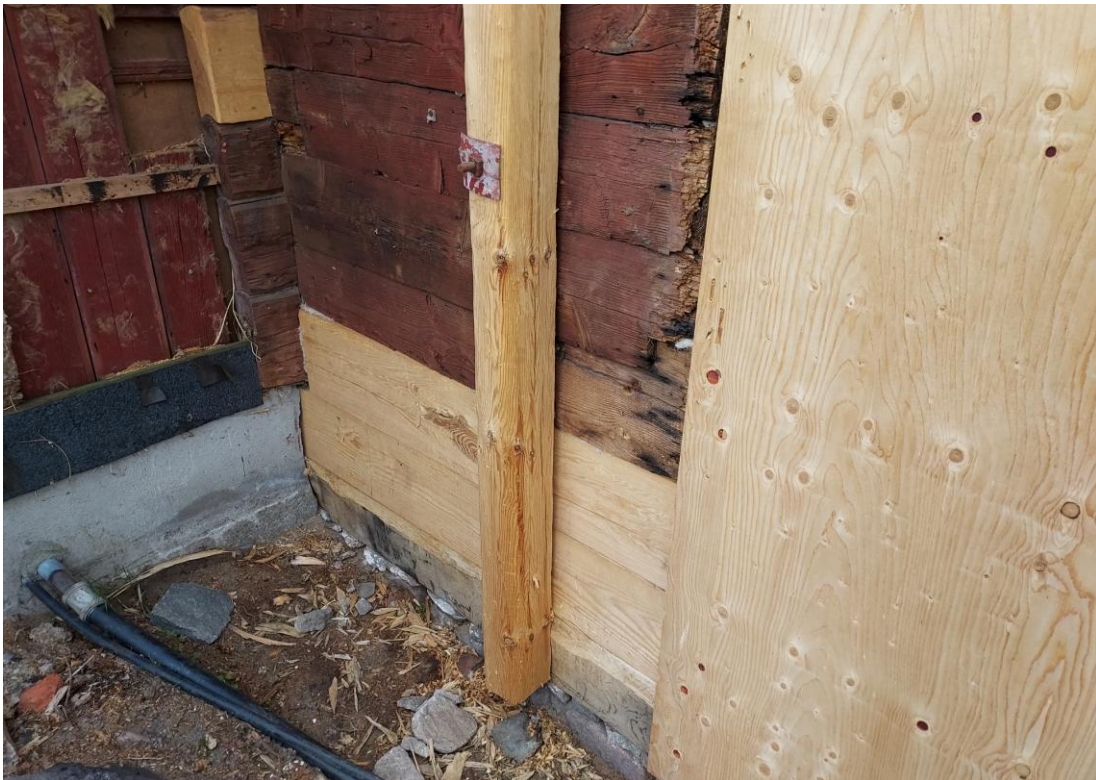
Fig. 20. Ny dragbalk monterad på södra fasaden. Notera de återanvända järndetaljerna.
