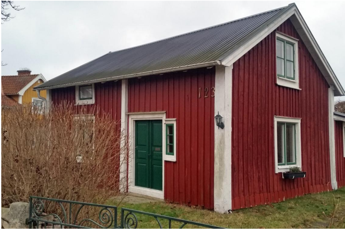
Fig. 15. Norra fasaden och västra gaveln, innan arbetet.
