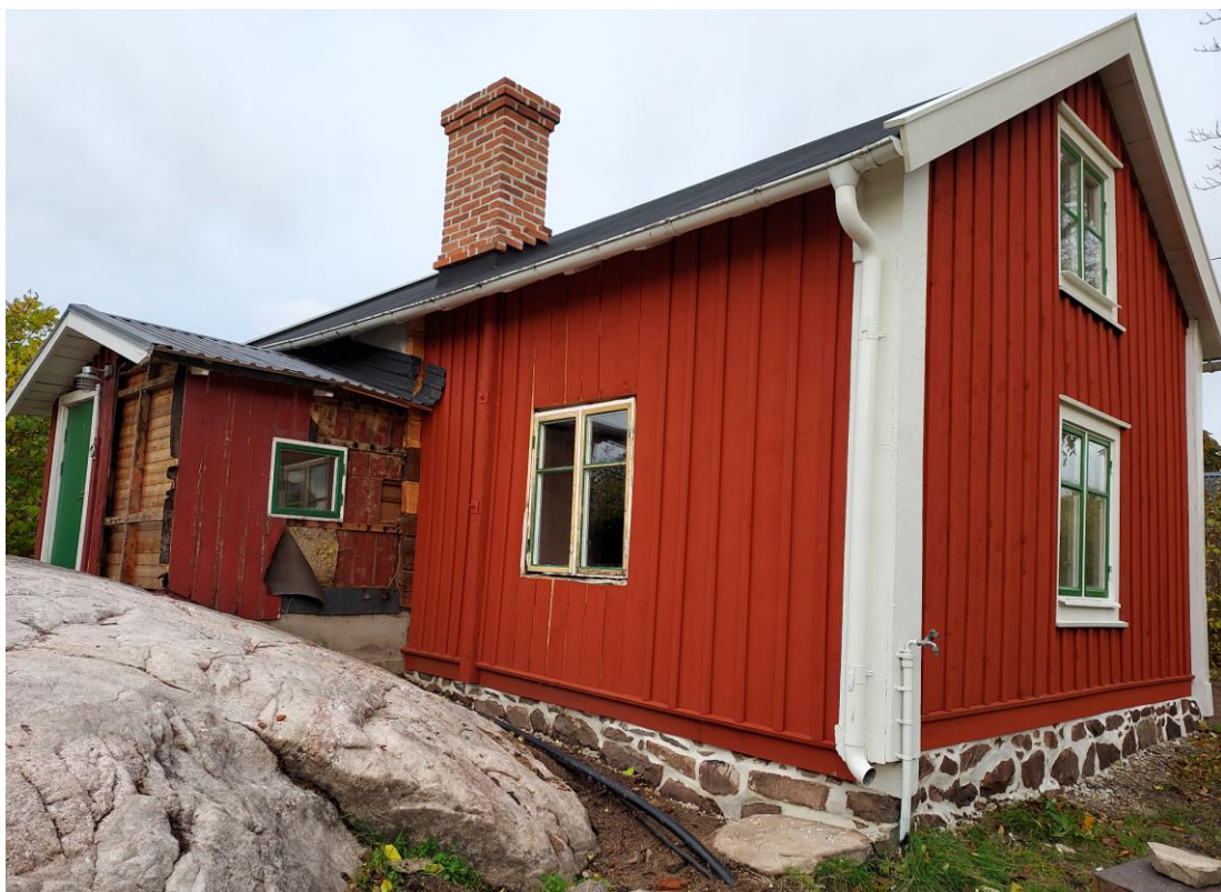
Fig. 22. Södra fasaden. Notera den borttagna gången och VA-ledningarna framför grundstenarna.
