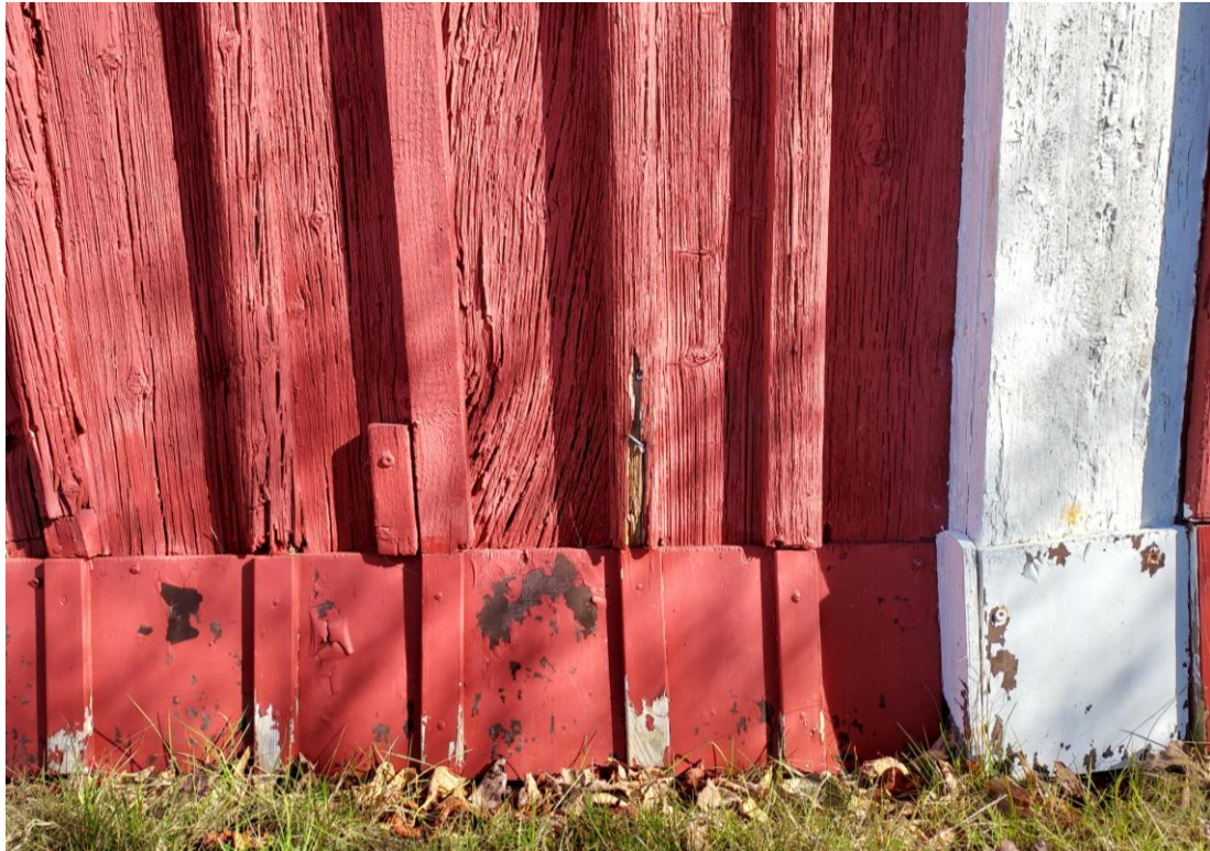
Fig. 17. Panelen innan arbetet, västra gaveln.
