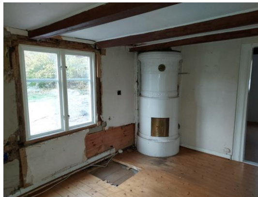
Fig. 14. Tre (av fyra) omfästa bindbjälkar.
