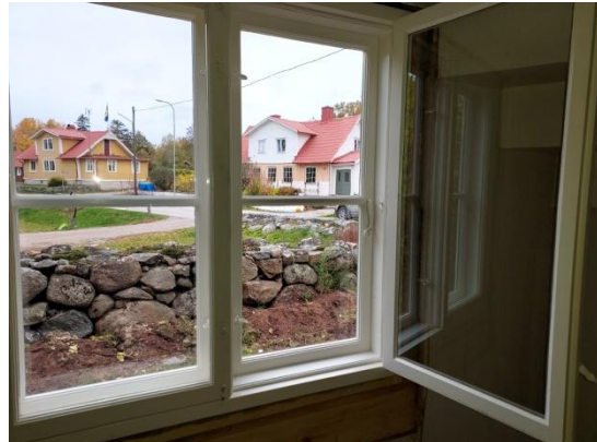
Fig. 26. Nyttillverkat fönster, västra gaveln.
