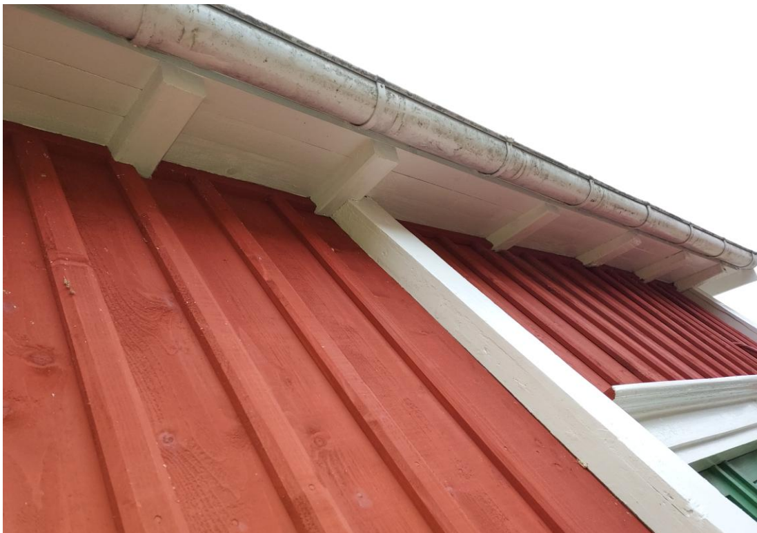
Fig. 8. Norra takfoten, med bytta takfotstassar och takfotsbrädor. Efter arbetet.
