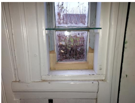
Fig. 5. Lagning av fönster, norra fasaden.
