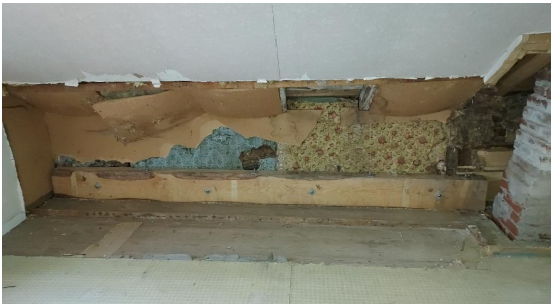
Fig. 12. Ryttarbjälke på vinden, längs med södra fasadens insida. Till höger skimtar den nya murstocken.
