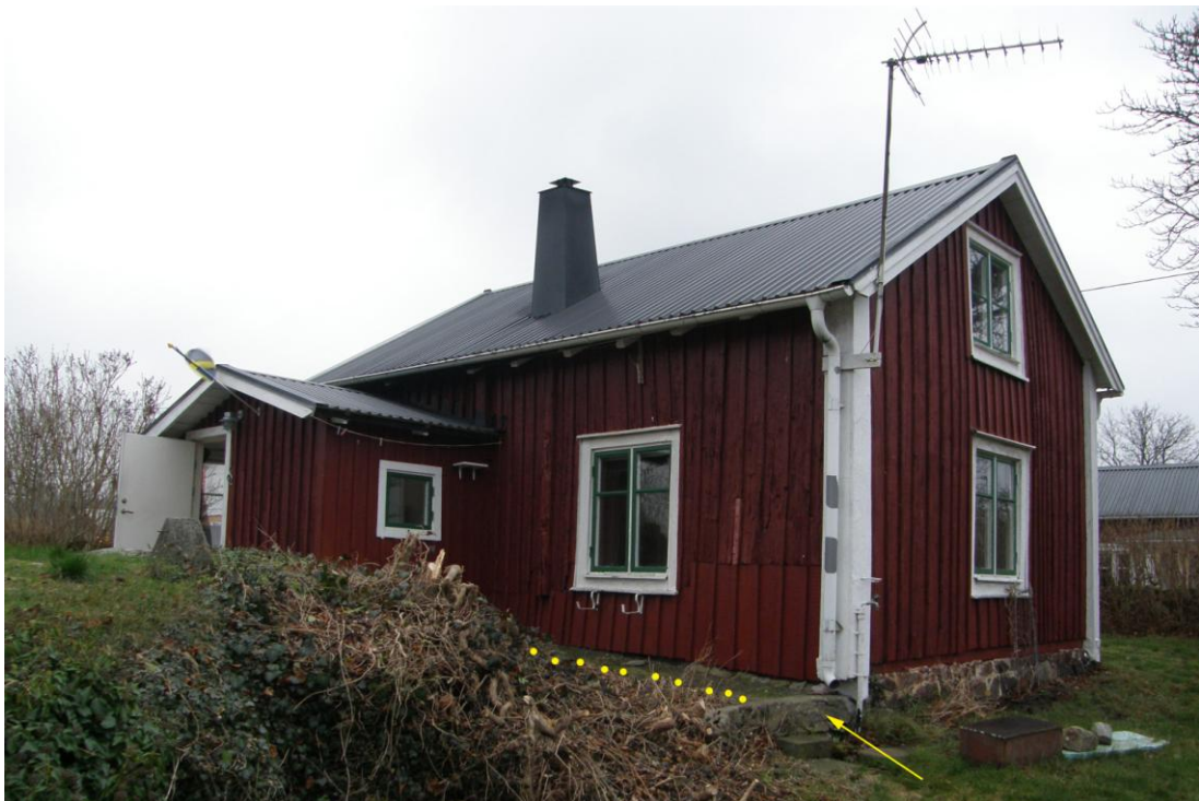
Fig. 16. Södra fasaden och östra gaveln, innan arbetet. Gula prickar markerar uppfylld gång, gul pil visar murad barriär.
