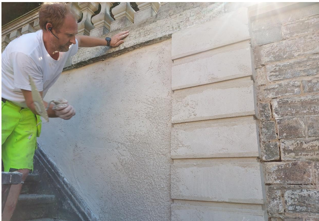
Fig. 2. Traditionell spritputsning av väggfälten.
