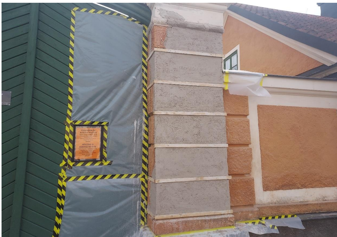
Fig. 3. Norra förbindelsemurens västra pelare, utsidan, under arbetet.
