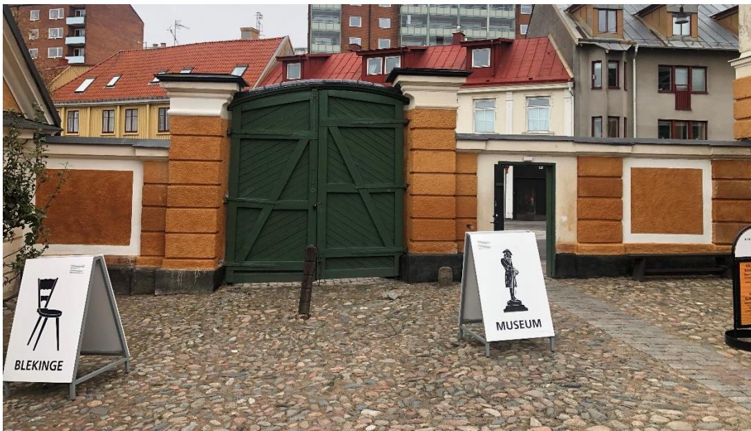
Fig. 8. Norra förbindelsemuren, efter arbetet. Foto Charlotta Gustafsson.
