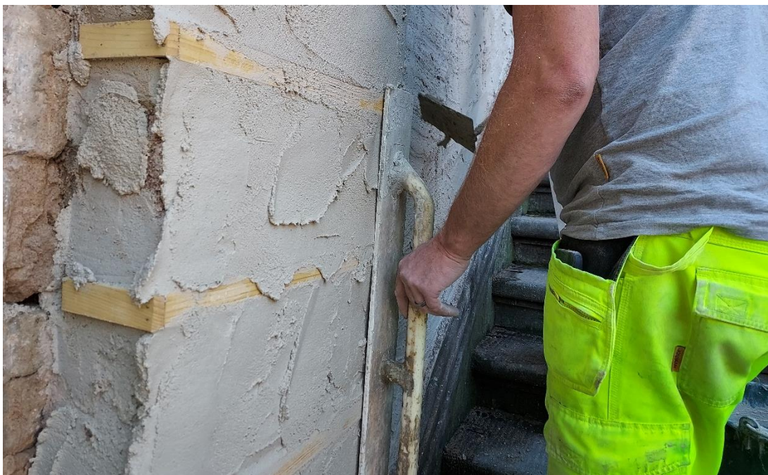
Fig. 1. Pilastrarna under omputsning. Notera trälisterna.
