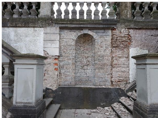
Fig. 11. Pilastrer efter rensning av puts.
