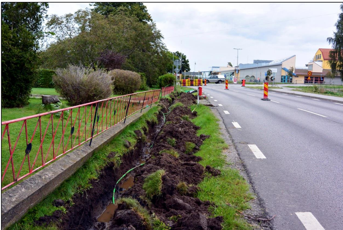
Fig. 4 – UO vid besiktning under pågående grävningsarbete.
