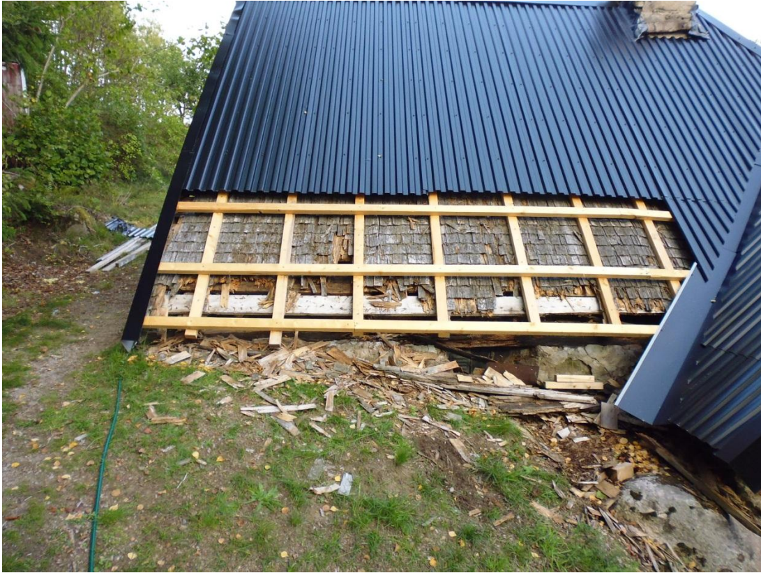
Fig. 1. Yttertaken täckta med plåt. Nedre plåtarna tillfälligt borttagna i samband med inspektion.
