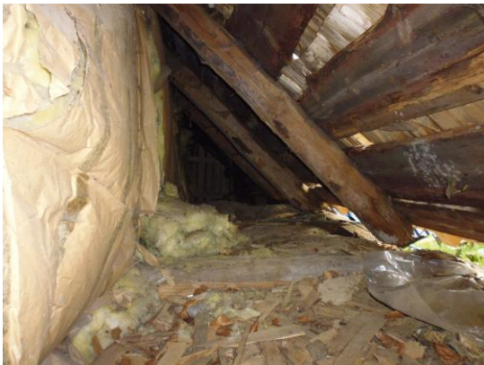
Fig. 2. Kryputrymmet med mineralisolering.
