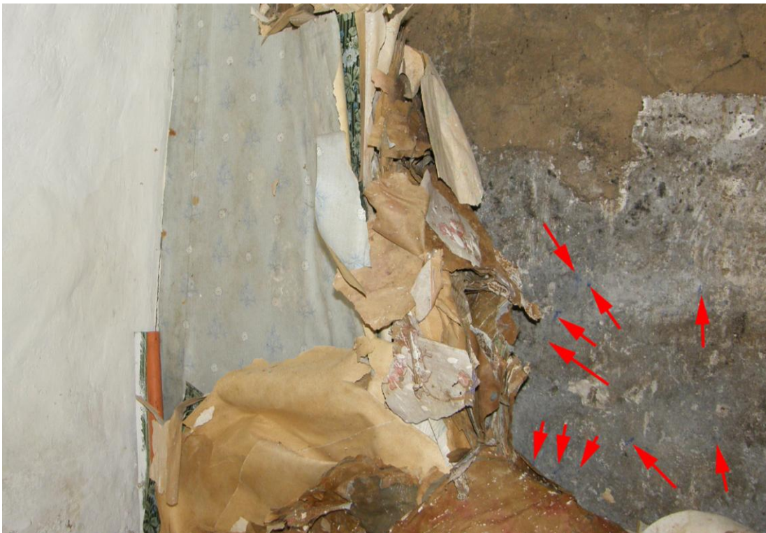
Fig. 6. Stugans västra vägg, Pilarna visar spår av ultramarinblått pigment.
