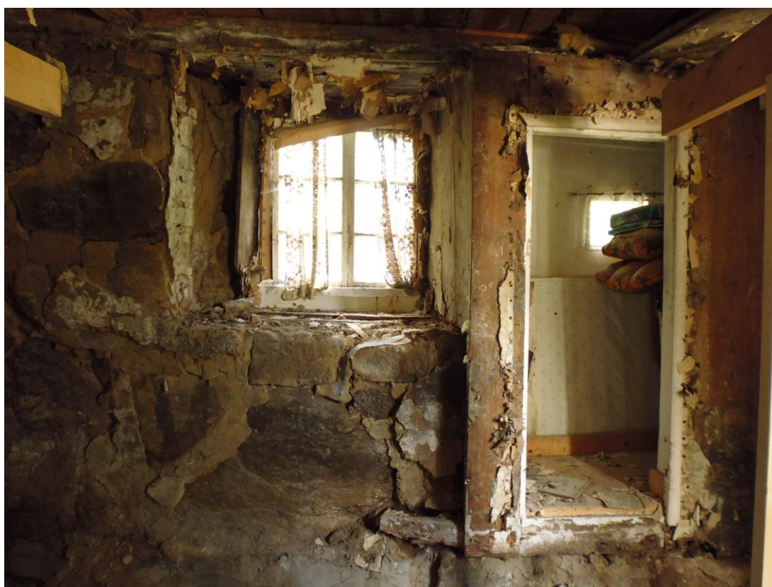
Fig. 4. Vy mot norra väggen.
