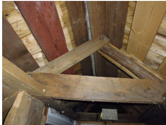
Fig. 11. Bultat sparrkryss, bräda och timmer.
