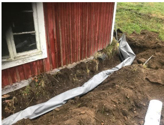
Fig. 16. Fiberduk kring dräneringsslangen.
