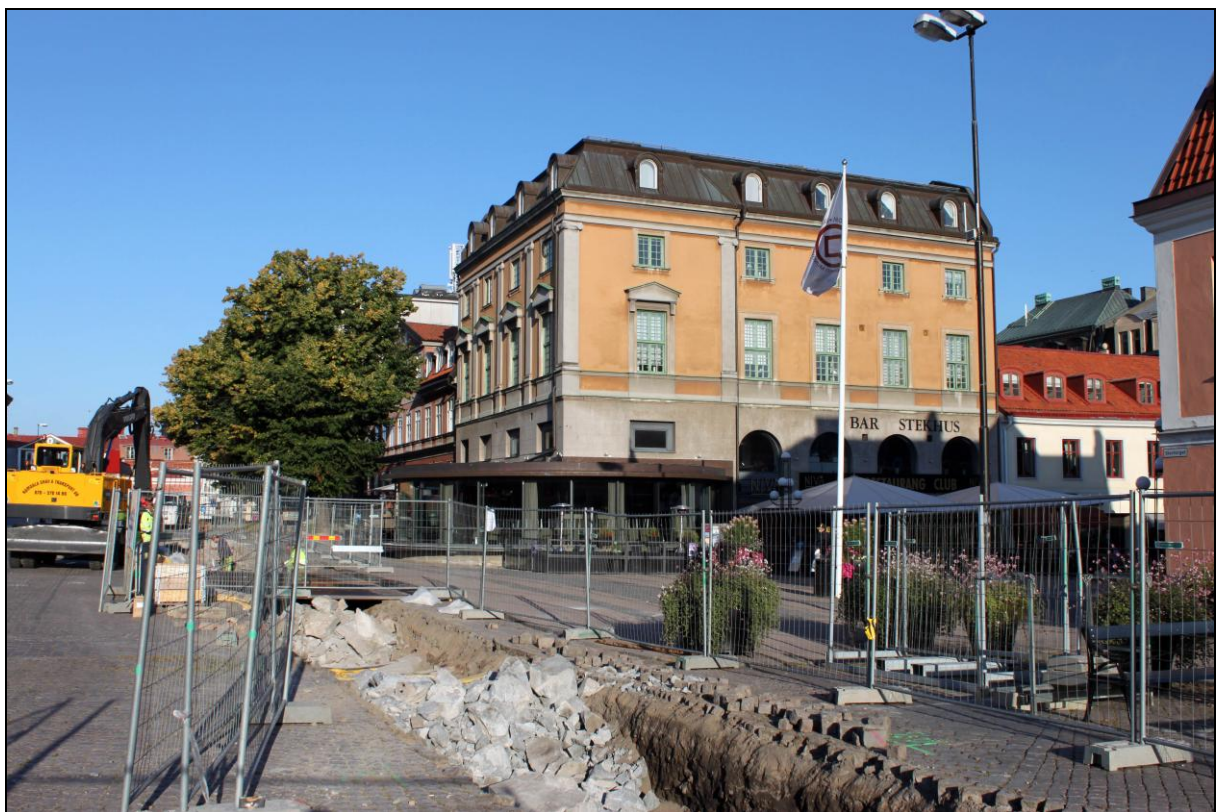
Överblick fjärrvärmeschakt mot VNV.
