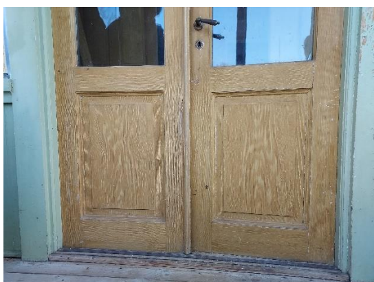
Fig. 6. Innerdörren, innan arbetet.
