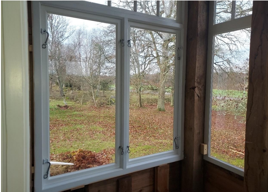
Fig. 12. Södra fönstret, efter arbetet.
