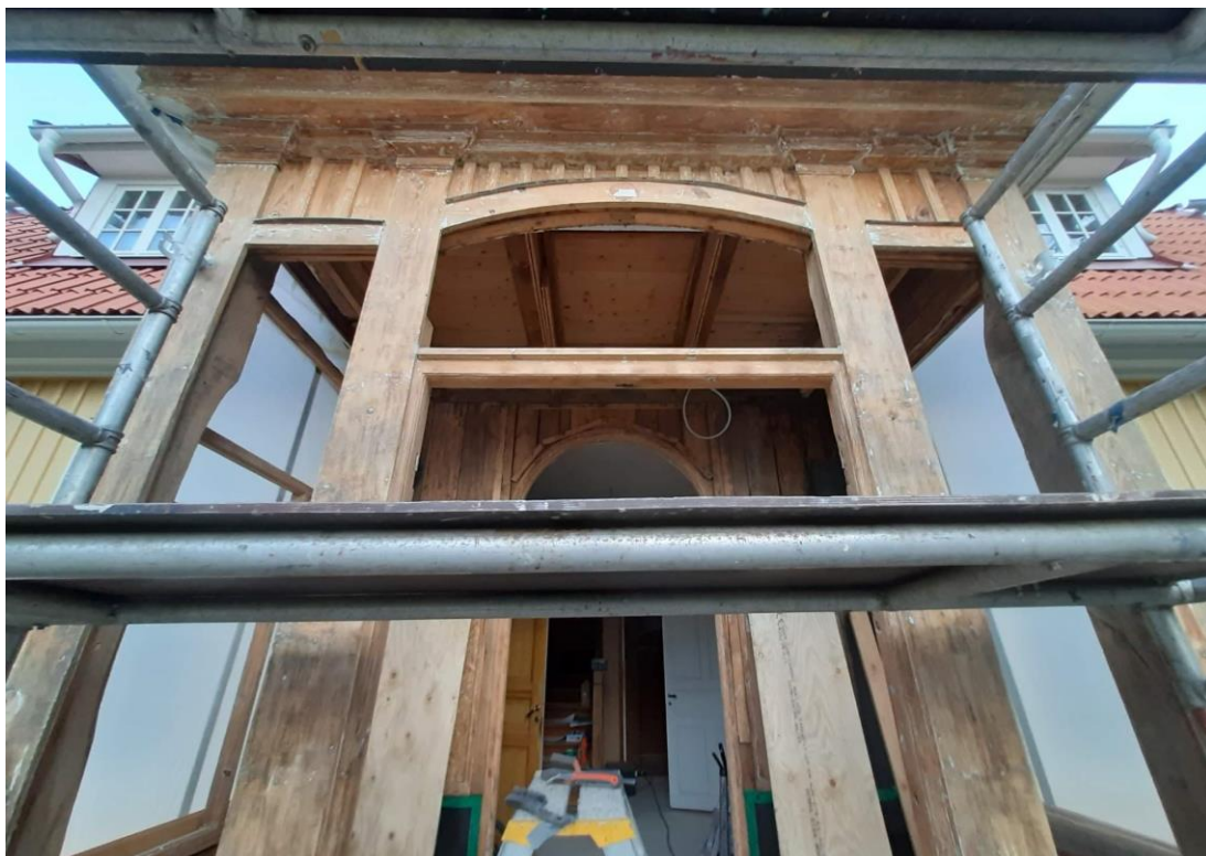
Fig. 10. Arbetsbild. Fönster och dörrar urtagna. Foto Lina Olsson och Daniel Prado.
