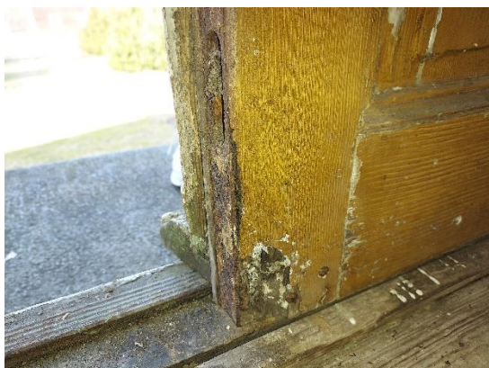
Fig. 4. Ytterdörren, detalj, innan arbetet.
