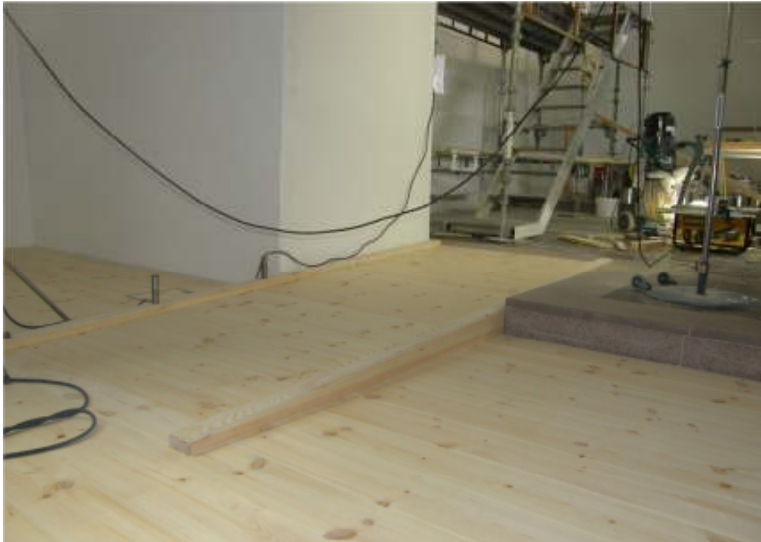
Fig. 5. Vy mot trärampen som leder in i koret. Innan slutbehandlingen av golvet.
