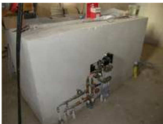
Fig. 13. VVS-reglage bakom altaret.
