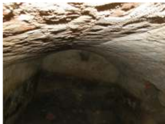
Fig. 18. Kryptan, vy mot söder.
