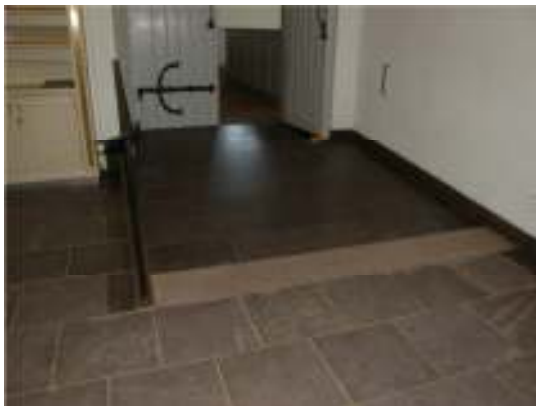
Fig. 9. Ny ramp i vapenhuset.
