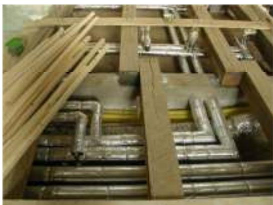
Fig. 11. Rödrugning för värmesystemet.
