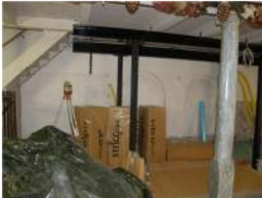
Fig. 7. Förstärkning av läktaren.
