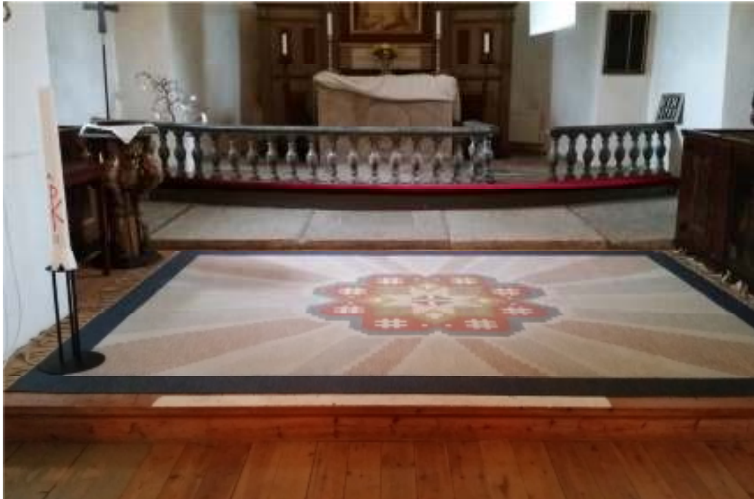
Fig. 19. Koret och absiden innan arbetet. Jämför med fig. 1 och 15. Notera korets tre golvnivåer, där den övre nivån följer altarringens inre form och den undre skapas vid gravstenarnas västra kant. Efter arbetet finns bara två nivåer, där den lägre nivån idag utgörs av gravstenarnas ovansida. Kryptan är belägen under gravstenarna.
