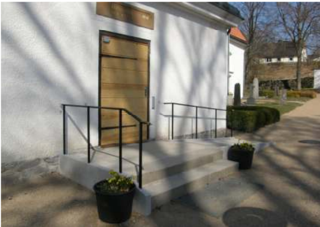
Fig. 16. Vapenhusets nyttillverkade dörr. Notera det förlängda vilplanet, rampen och räcken.
