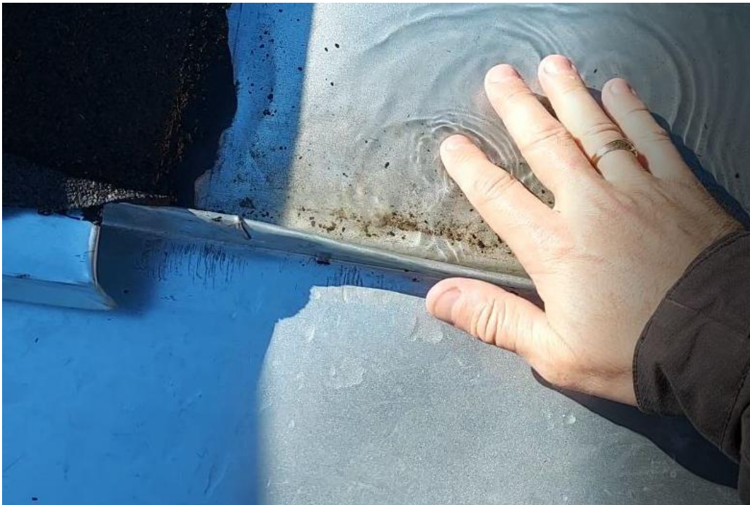
Fig. 9. Ej avrunnet regnvatten, innan nedhamringen av falsen.
