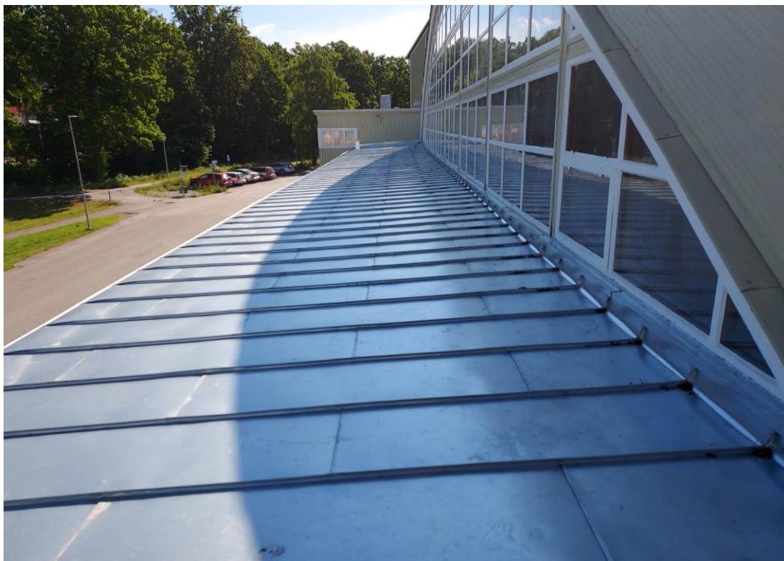
Fig. 14. Taket efter arbetet.
