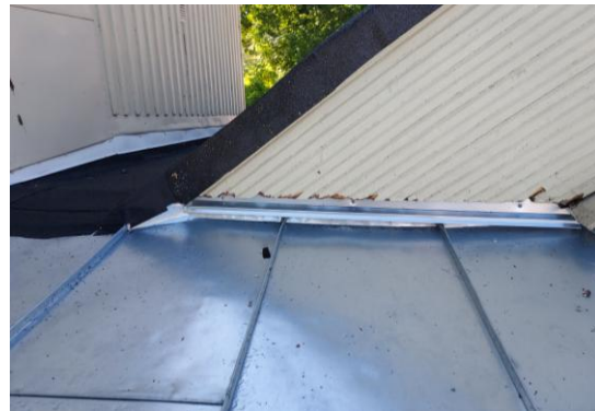
Fig. 3. Möte mellan gavel och nytt plåttak.
