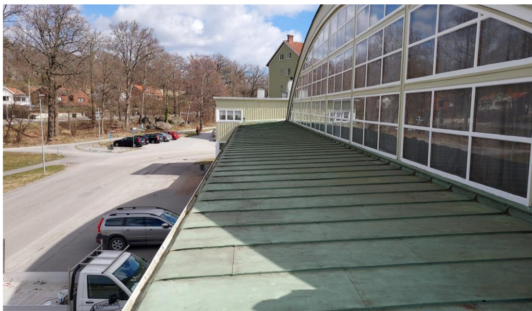
Fig. 1. Taket innan arbetet. Norr är till vänster. Jämför med fig. 14.
