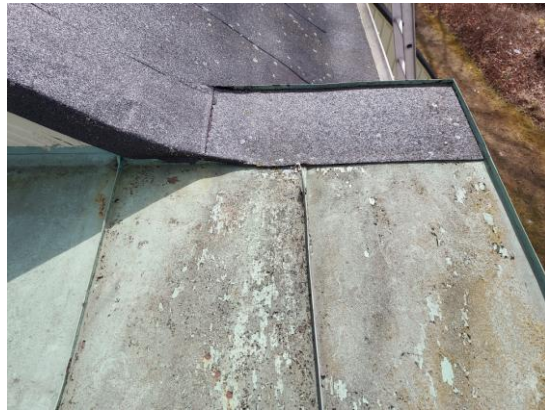
Fig. 7. Nerhamrad fals, nordvästra hörnet. Fig. 8. Samma hörn, innan arbetet.
