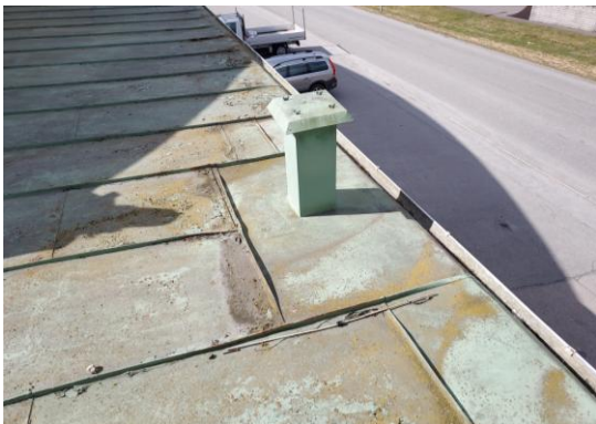
Fig. 4. Takventilen innan arbetet.
