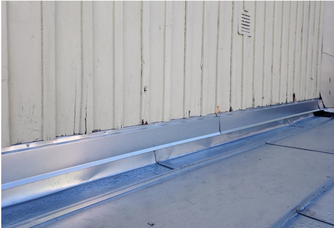
Fig. 6. Panelparti i mötet mellan plåt och trä, östra högdelen.
