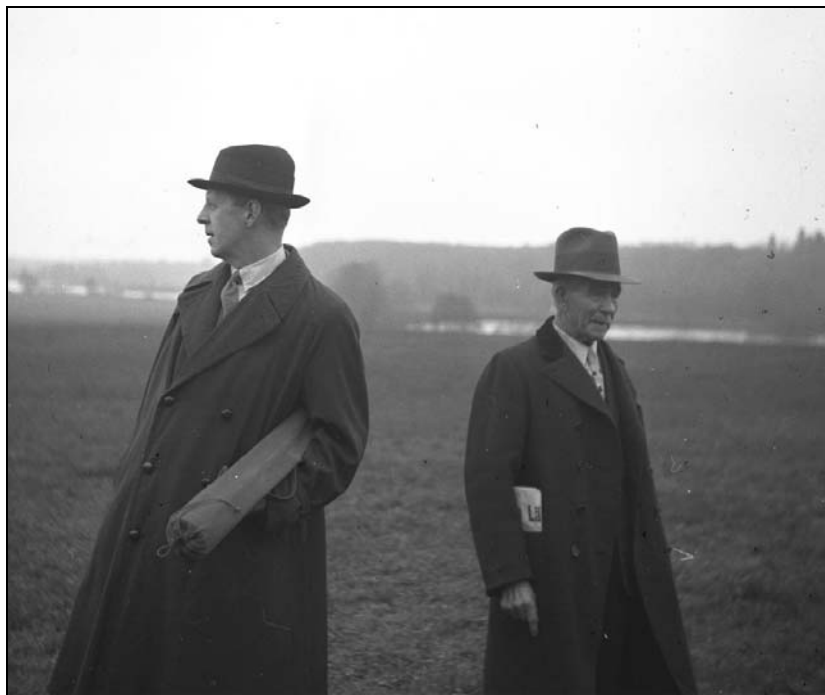
Fig.2 - Leander och Johansson vid besiktningen av Ekebacksgärdet i Augerum 1938 .
