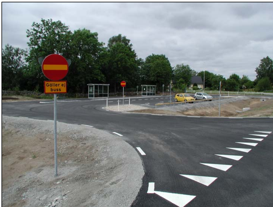
Fig.5 – Färdigställd bussterminal, fotograferad mot N.
