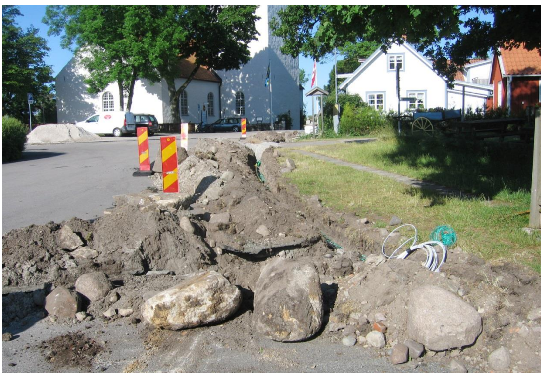
Figur 11 Linjesträckningen ned mot hamnplanen. Större, kraftiga stenar framkom i schaktet
