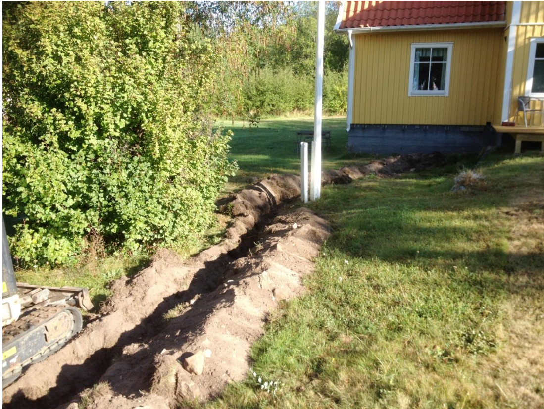
Figur 7 Anslutning till fastighet, den till höger i bild synliga förhöjningen i markytan är en rest av Skräddarbastionens mur. (jfr fig.6)
