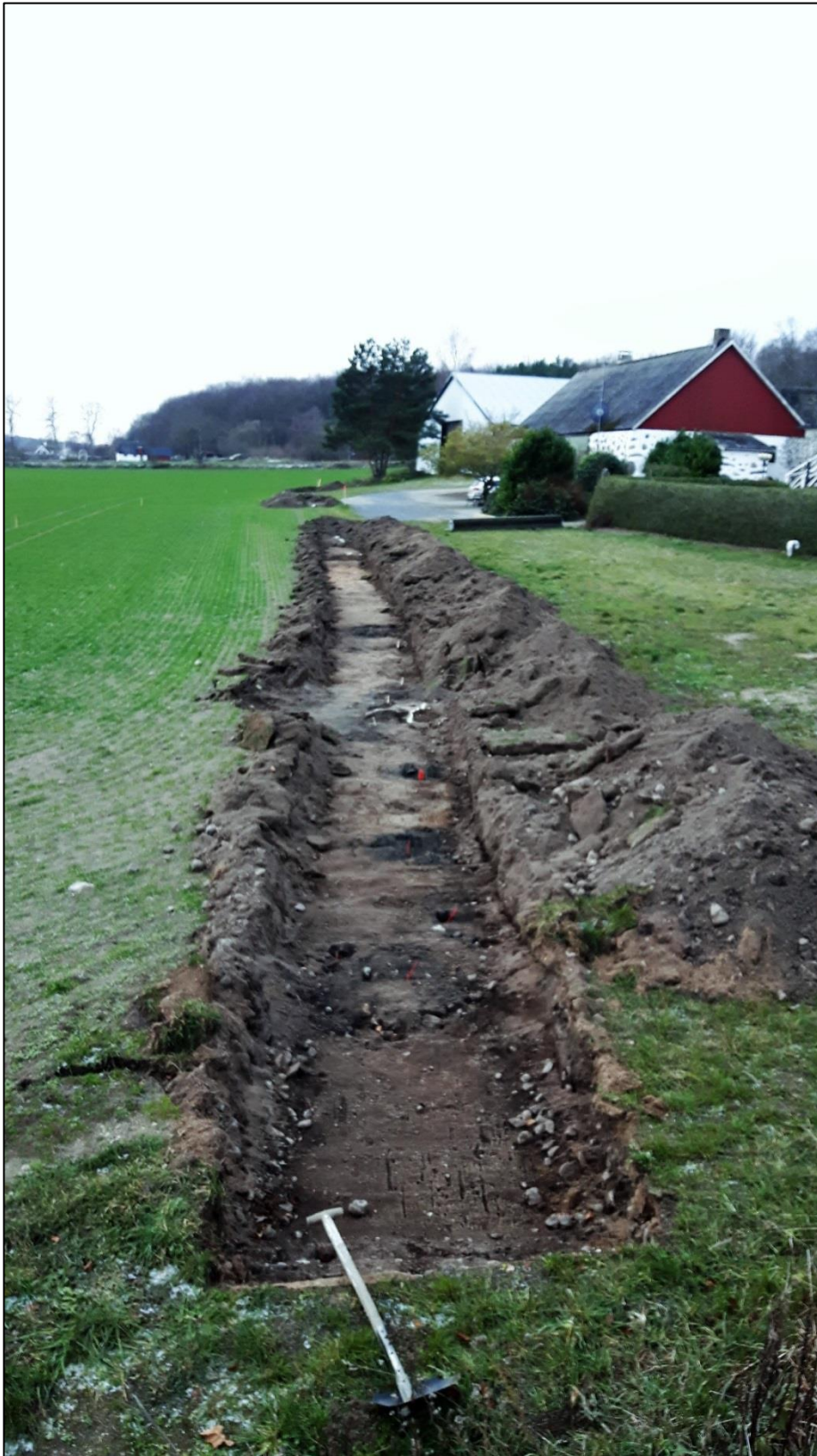
Figur 8. Schakt 22 fotograferat mot söder. Man kan notera att schaktets norra del inte är nedplöjd till alven. (Foto: Carl Persson)
