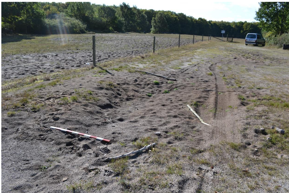
Figur 3. Den skadade ytan innan undersökningen påbörjades. Man kan i bildens förgrund se områden med öppen sand inom parkeringen. Avsaknaden av bärlager medför en stor risk för nya körskador. Bakom stängslet kan helt söndertrampade och eroderade ytor ses. I sanden återfanns stora mängder flinta och skörbränd sten.
