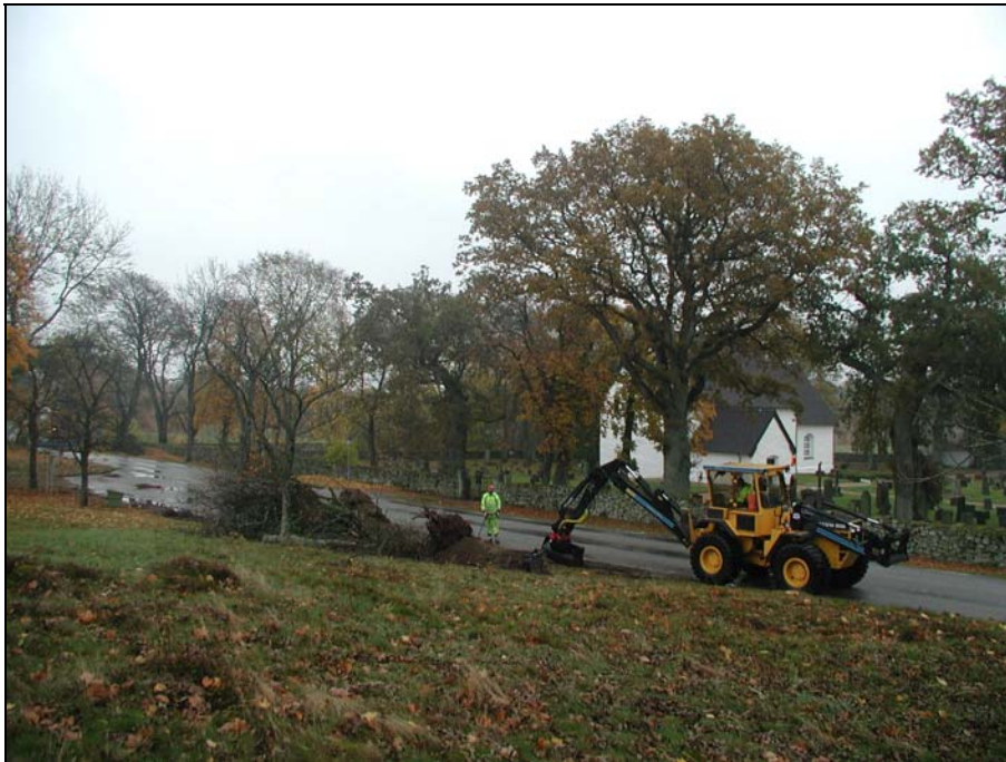
Fig.2 – Påbörjad schaktning, överblick mot NO.
