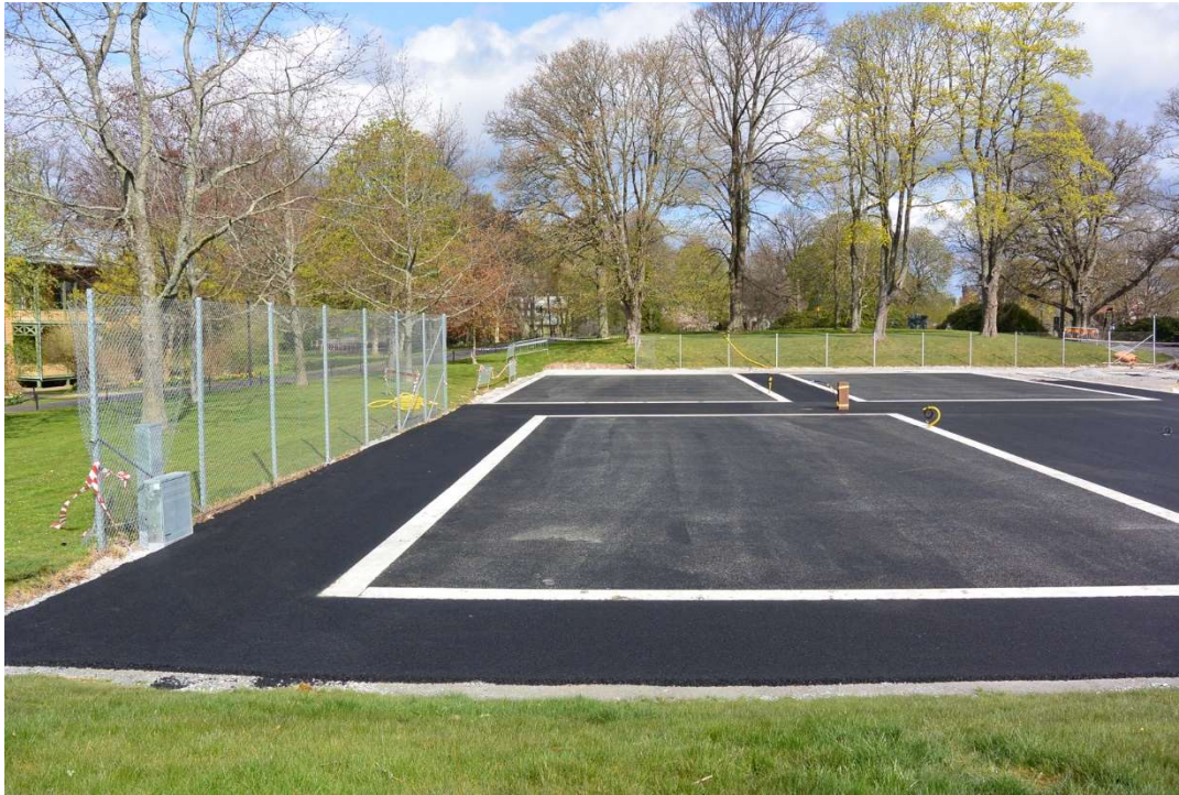
Fig. 12. Betongramarna är på plats och padelbanorna har täckts med dräneringsasfalt, övriga ytor med vanlig asfalt. (Jfr fig. 10 och 14.)
