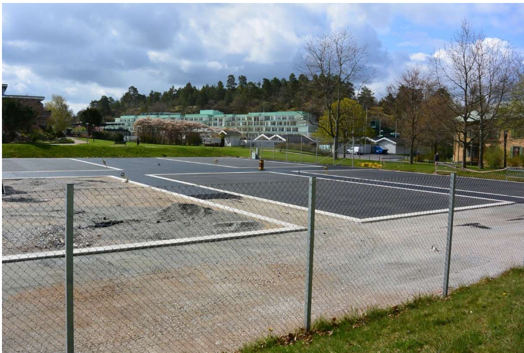
Fig. 13. Pågående markarbeten och asfaltering, vy mot söder (Jfr fig. 15 och 21.)
