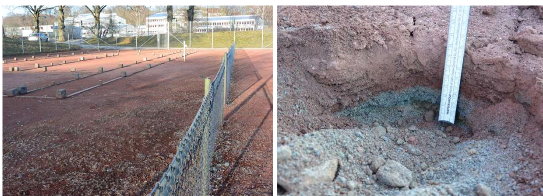
Fig. 7. Tennisbanorna, vy mot nordost före arbetet. Fig. 8. Tennisbanornas övre markskikt bestående av röggrus och bärlager.
