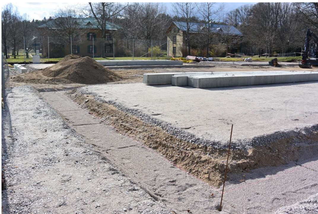
Fig. 11. Pågående markarbeten, vy mot väster.
