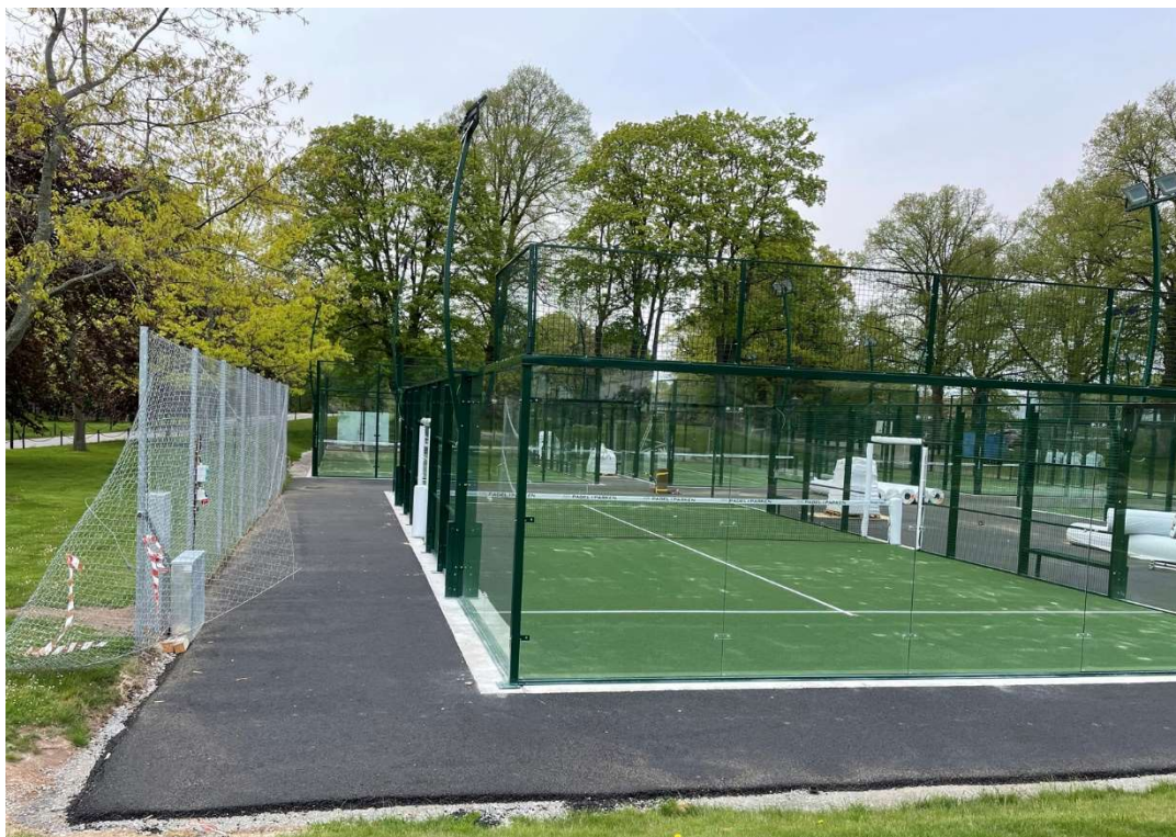
Fig. 14. Glas- och gallerpartier är monterade och konstgräs lagt på den sydvästra banan, en av de två panoramabanorna. (Jfr fig. 10 och 12.)
