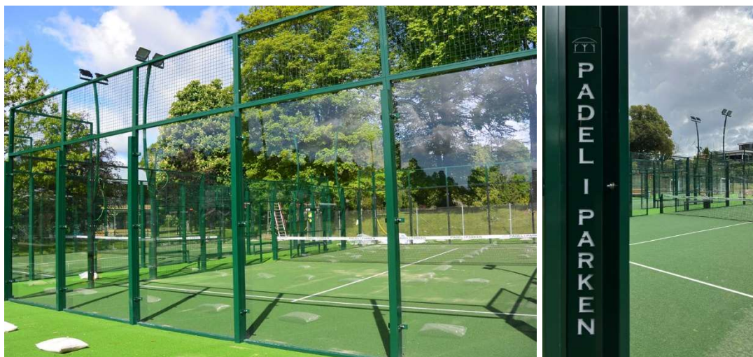
Fig. 16. Stålkonstruktionen är lackerad i Brunnsparkens enhetliga gröna kulör. De vita små säckarna med finkornig silikatsand är jämnt placerade inför spridning. Fig. 17. Anläggningens namn och logotype på en av hörnstolparna.
