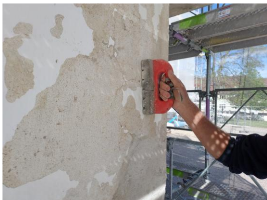
Fig. 13. Slipning med golvsten.
