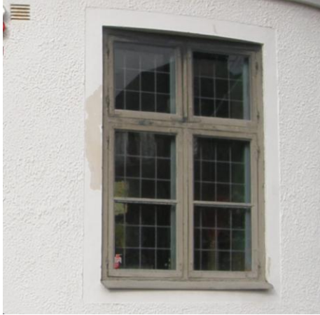
Fig. 17. Fönster innan arbetet.
