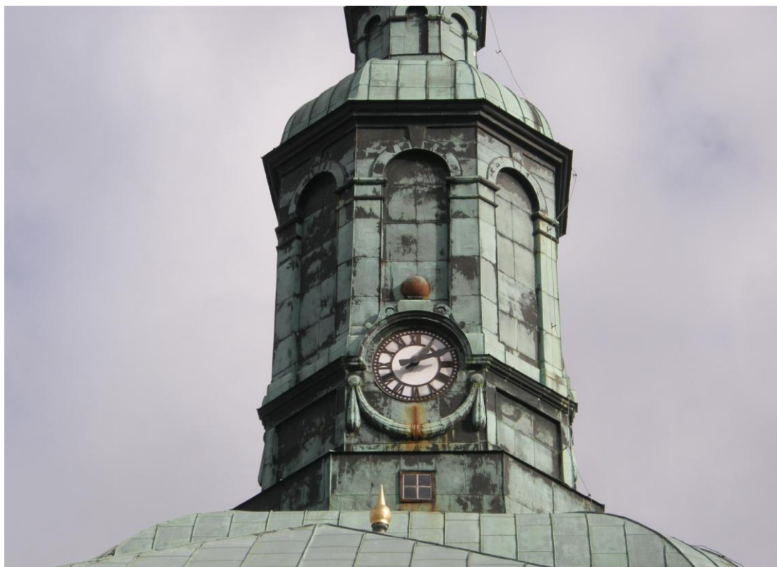
Fig. 2. Lanterninerna innan arbetet.
