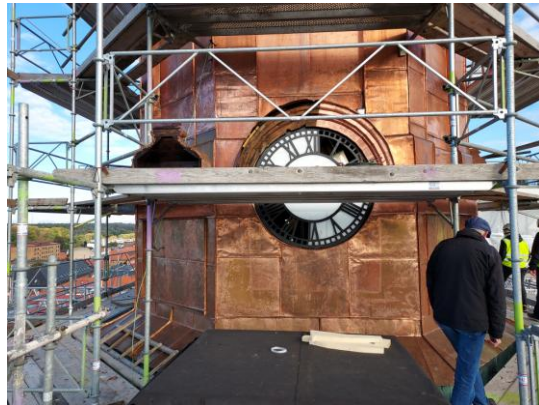
Fig. 34. Undre lanterninen, under arbetet.
