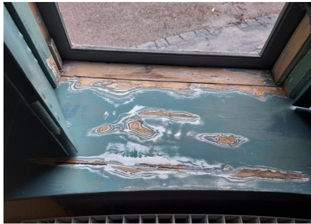
Fig. 18. Uppskrapning och slipning av karm.
