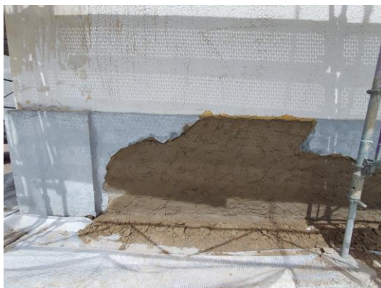
Fig. 15. Utstockning av grund.
