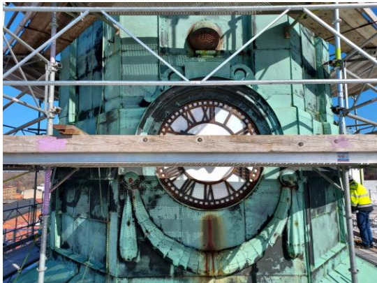
Fig. 33. Undre lanterninen, innan plåtbytet.
