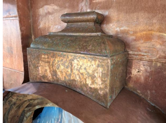
Fig. 8. Renoverad och återmonterad akroterie.
