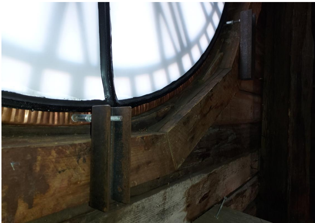
Fig. 30. Infästning för urtavlor mot lanterninens stomme.
