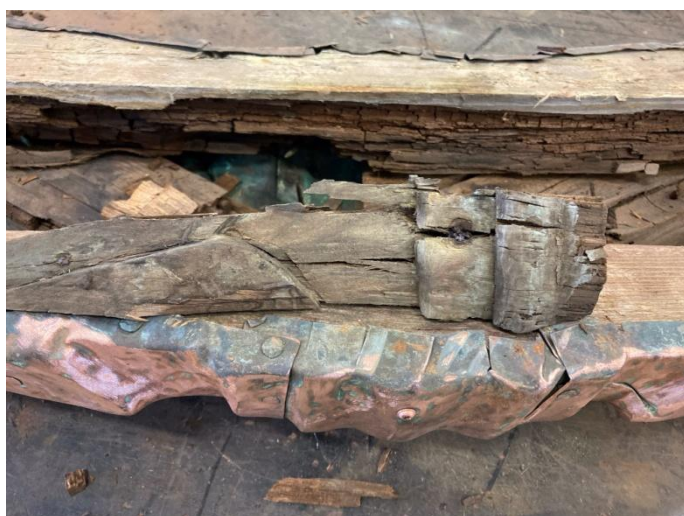
Fig. 5 (t.v.). Festongerna nedtagna och rengjorda. Fig. 6 (t.h.). Förbrukad snidad träfyllning i festong. Foto Ivar Venster, 2022.
