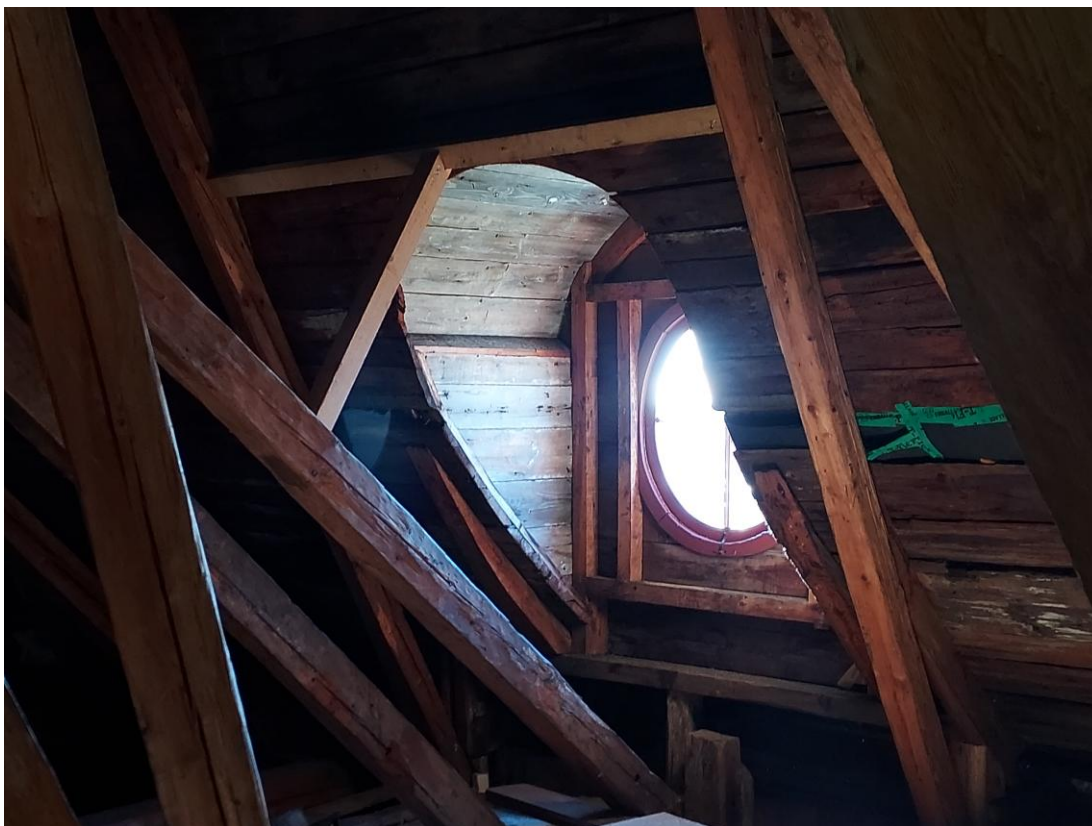
Fig. 25. Stabilisering av kuptak.
