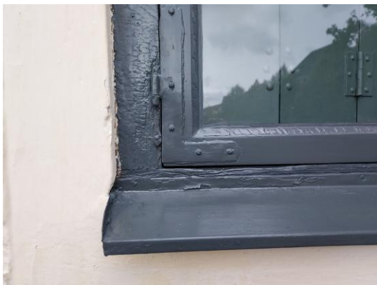
Fig. 21. Detalj på färdigmålat fönster.
