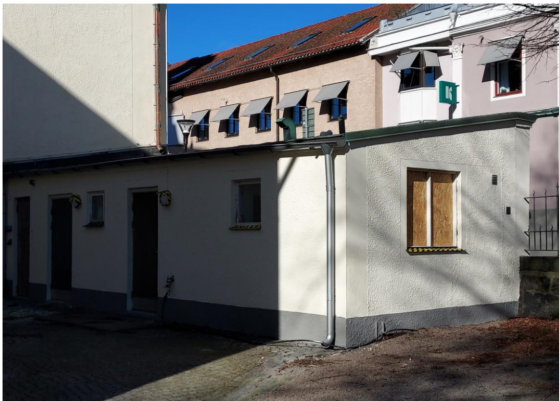
Fig. 35. Servicebyggnaden efter ommålning. Fönstren ej färdigmålade.
