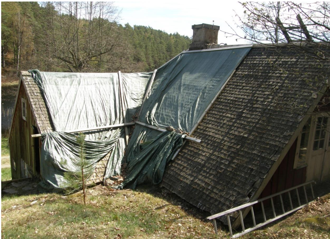
Fig. 3. Vinkeltillbyggnaden, fastspikad presenning som skyddar rännan.
