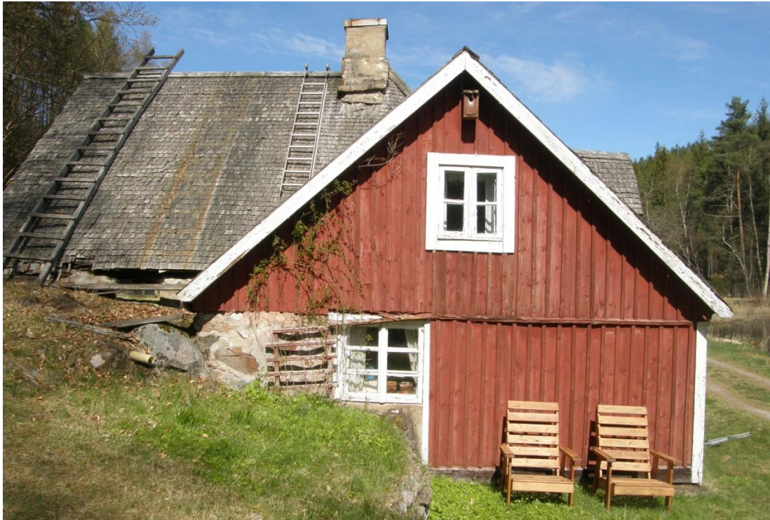
Fig. 10. Vy mot södra gaveln.
