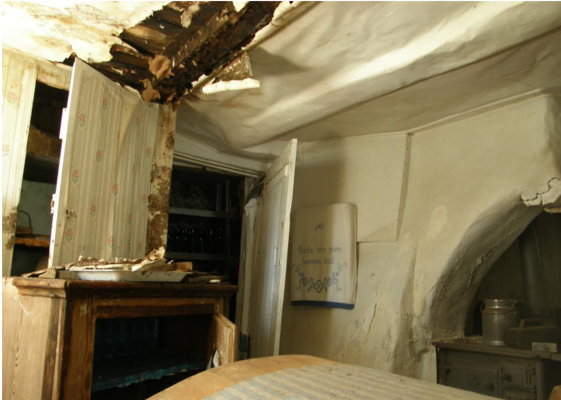
Fig. 18. Takskadan i köket. Notera skafferiet.
