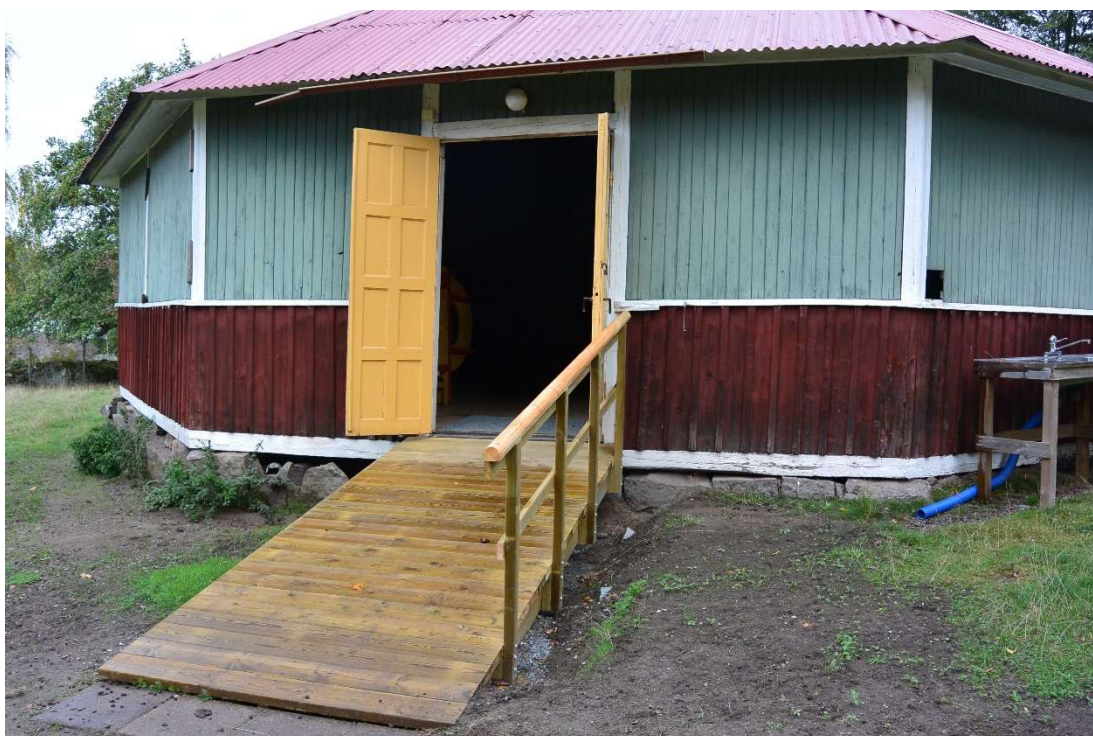
Fig. 4. Färdigställd ramp, jfr fig. 1.
