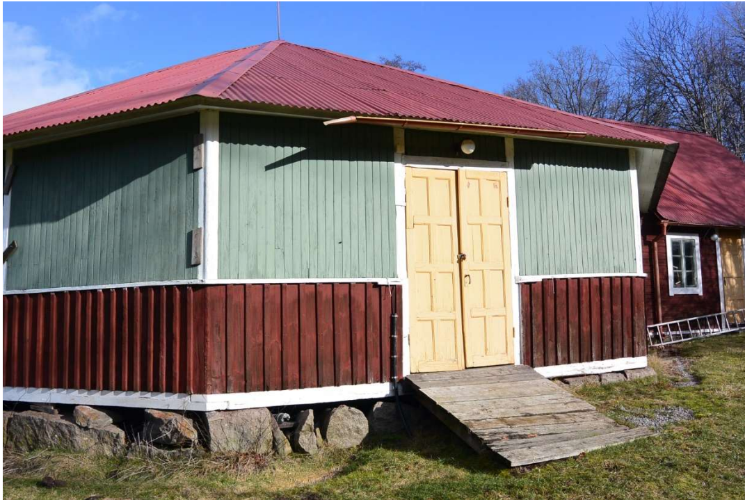
Fig. 1. Dansbanans entré med den gamla rampen före arbetet.
