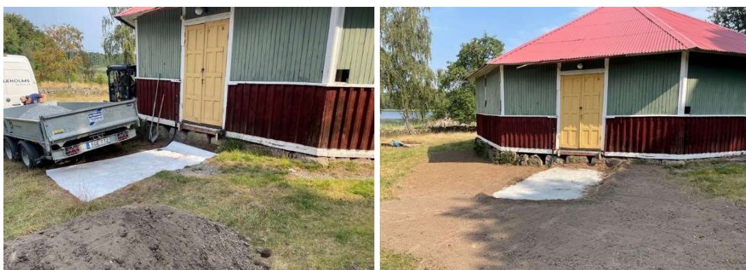
Fig. 2 och 3. Pågående markarbeten i anslutning till rampen.
