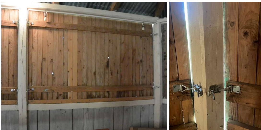
Fig. 11 och 12. Luckorna efter arbetet, försedda med excenterlås och flyttbara enkelblock.
