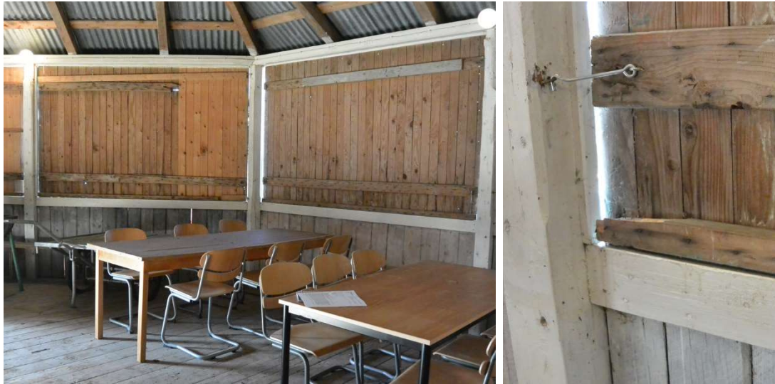
Fig. 9 och 10. Dansbanans demonterbara luckor med haspar, före arbetet.
