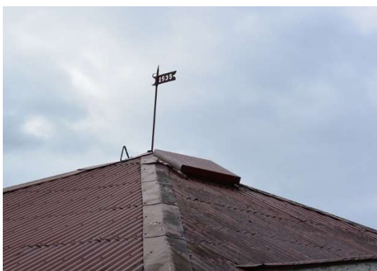
Fig. 7. Utsidan av takluckan efter arbetet. Fig. 8. Insidan av luckan efter arbetet. Hävstång och skena är återanvända.
