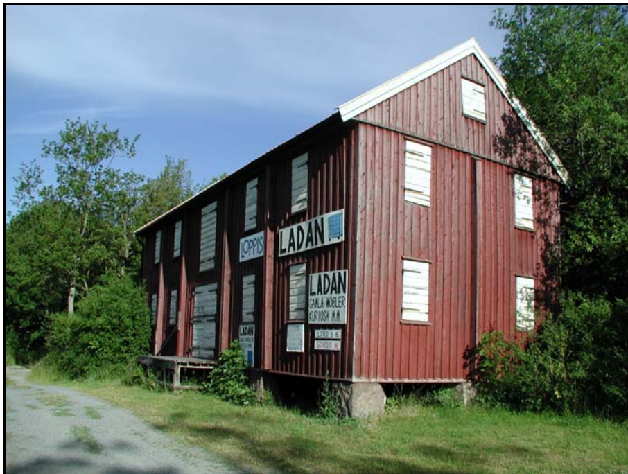
Fig.3 – "Prylladan" i den sydöstra delen av utredningsområdet, fotograferad mot NV.
