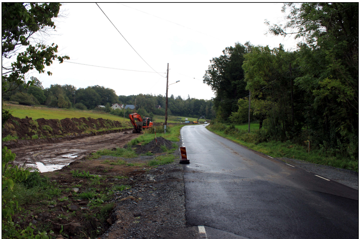
Huvudschaktet fotograferat mot SO.
