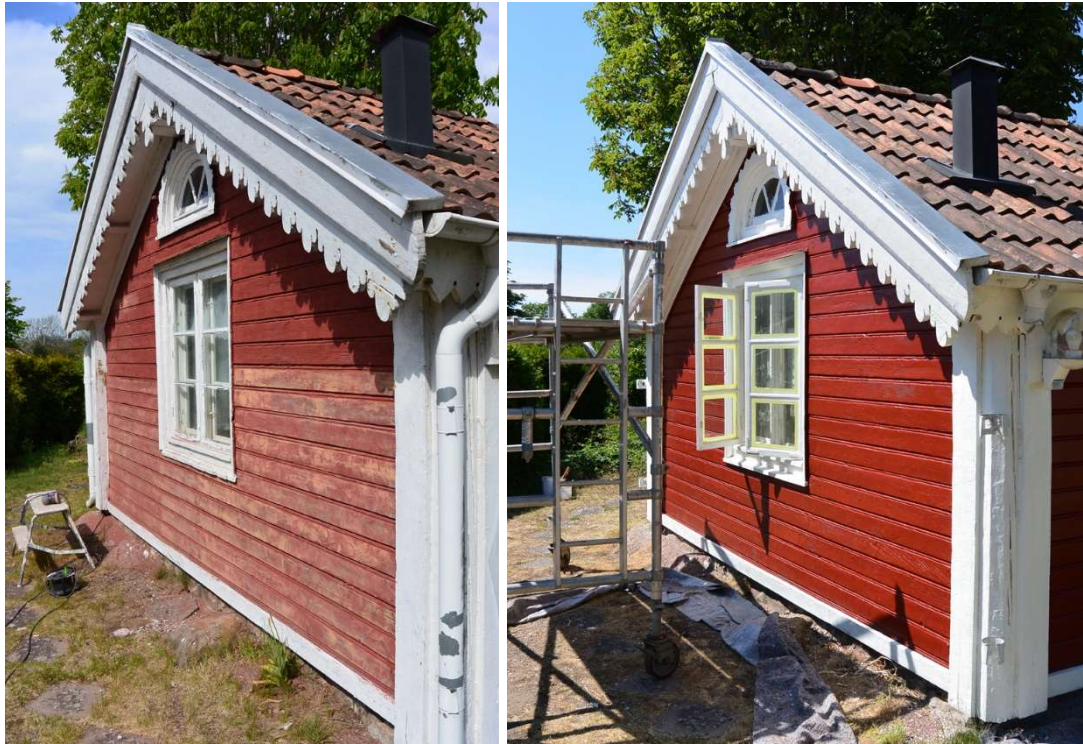
Fig. 8. Pågående slipning av södra gaveln. Fig. 9. Södra gaveln i slutskedet av arbetet.
