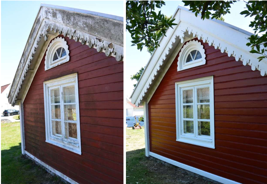
Fig. 12 och 13. Norra gaveln före och efter arbetet. Den dekorativa snickarglädjen under vindskivan närmast i bild byttes.
