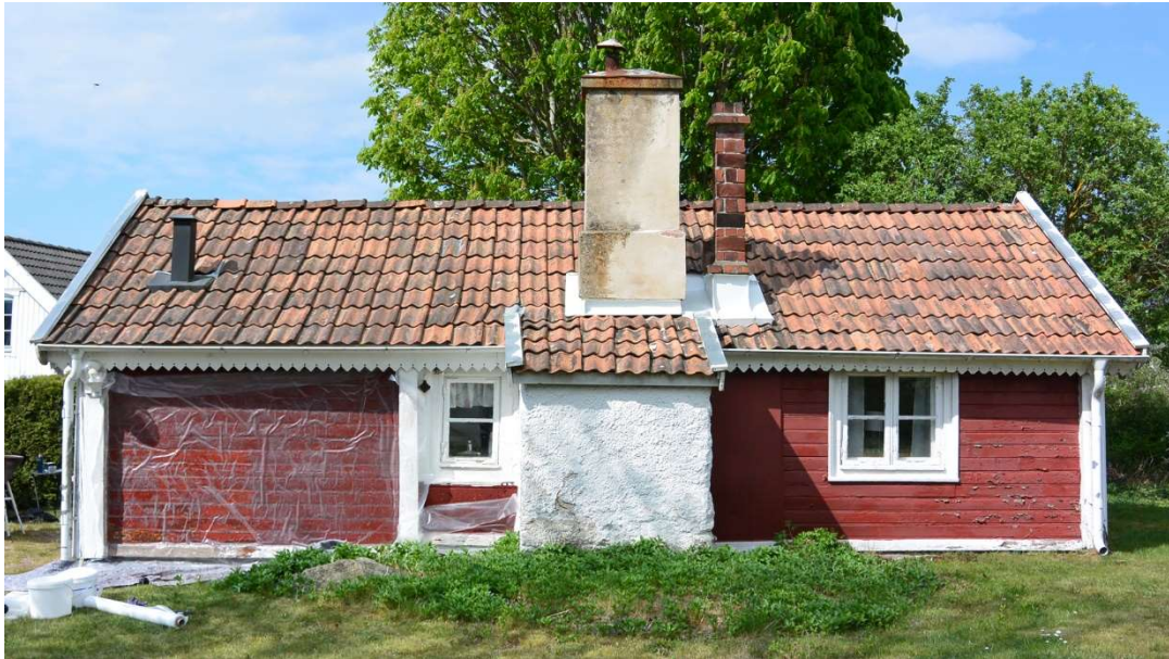
Fig. 5. Östra fasaden. Färgborttagningsmedlet har påförts och packats in i plast.
