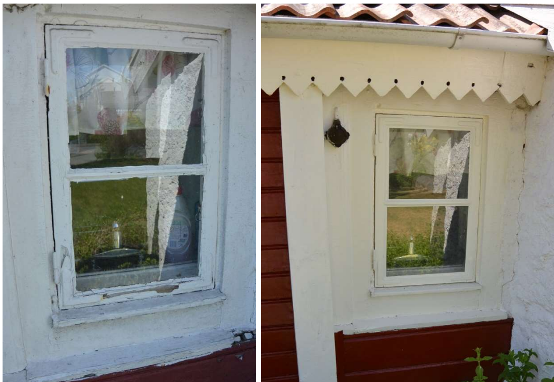
Fig. 14 och 15. Köksfönstret, invid murstocken utmed östra fasaden, före och efter renovering.
