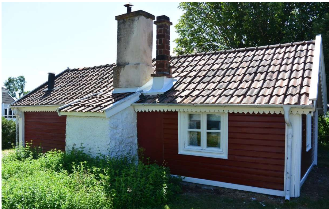
Fig. 16. Östra fasaden efter arbetet.
