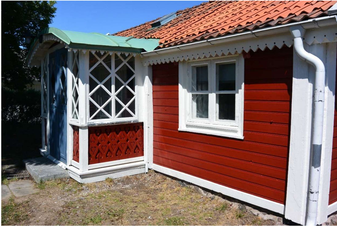
Fig. 17. Västra fasaden och verandan efter arbetet.
