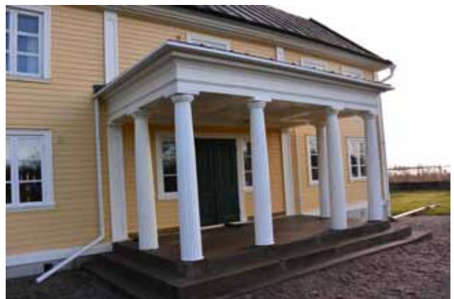
Tre av Gräbbegårdens kolonner restaurerades.
