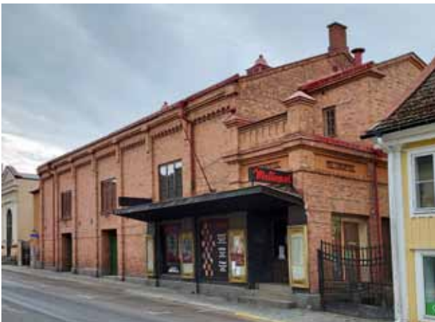
Taket på biografen Metropoli i Sölvesborg lades om.
