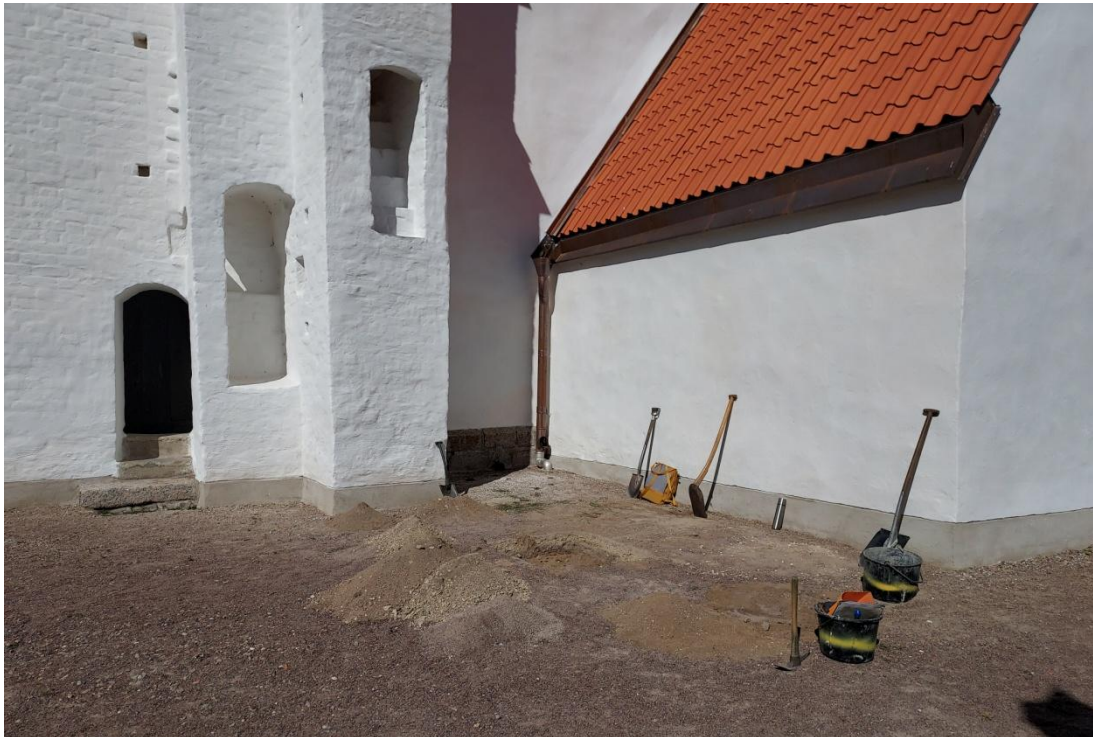
Fig. 2. Vy mot sydöstra kontreforen. Upptagna schaktmassor lades i separata lagerhögar och återfylldes i den ordning de återfanns.
