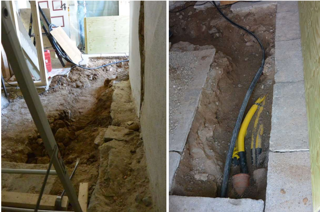
Fig. 29. Uppgrävt schakt mot vapenbuset. Fig. 30. Befintlig VA-anslutning under golvet i vapenbuset.
