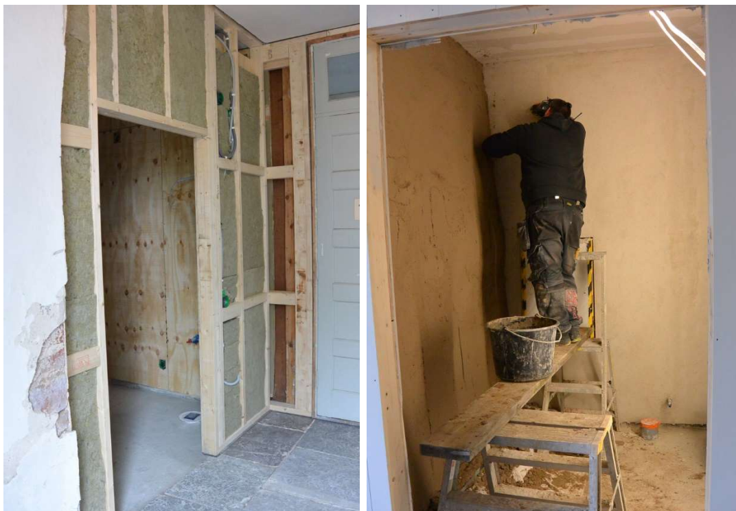
Fig. 17. Utrymmet för RWC under arbetet, vy från vapenhuset. Fig. 18. Den västra väggen i RWC (yttermurens insida) putsades om.
