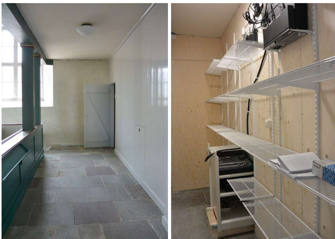
Fig. 9. Den nya panelväggen med enkel dörr och infällt ljudskåp, jfr fig. 5. Fig. 10. Insidan av det nya utrymmet, vy mot norr, med hyllor och ljudskåp.
