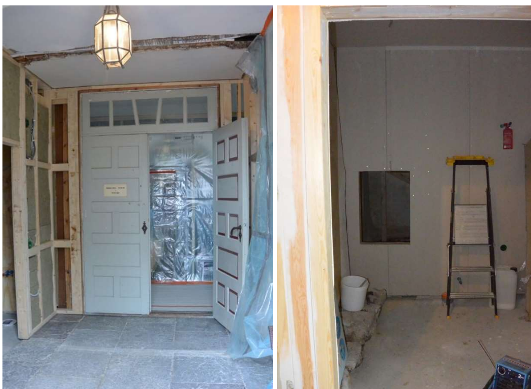
Fig. 36. Vapenhuset, under arbetet. Pardörren har flyttats. Fig. 37. RWC under arbetet.
