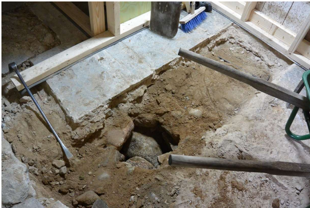
Fig. 28. Under den stenlagda ytan fanns större naturstensblock lagda ovanpå markytan.
