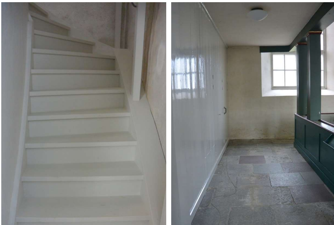
Fig. 38. Monterad ny trappa. Fig. 39. Den norra delen av läktarunderbyggnaden, vy mot norr, jfr fig. 6 och 14.
