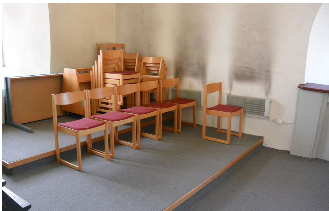
Fig. 21. Läktarens nordvästra hörn, före arbetet.
