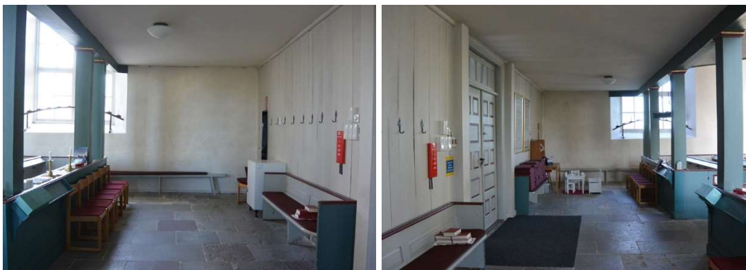
Fig. 5 och 6. Utrymmet under läktaren, vy mot söder respektive norr, före ombyggnad.
