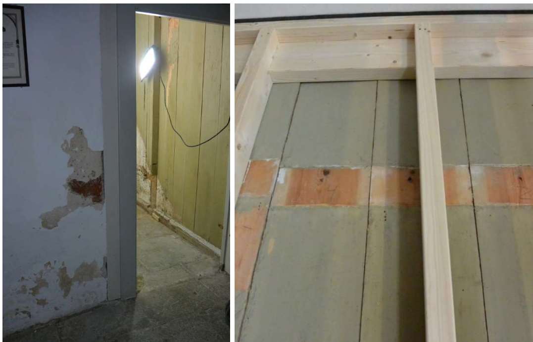
Fig. 34. Utrymmet för RWC under arbetet, vy från vapenhuset. Fig. 35. Insidan av grönmålade flyttade panelbrädor.
