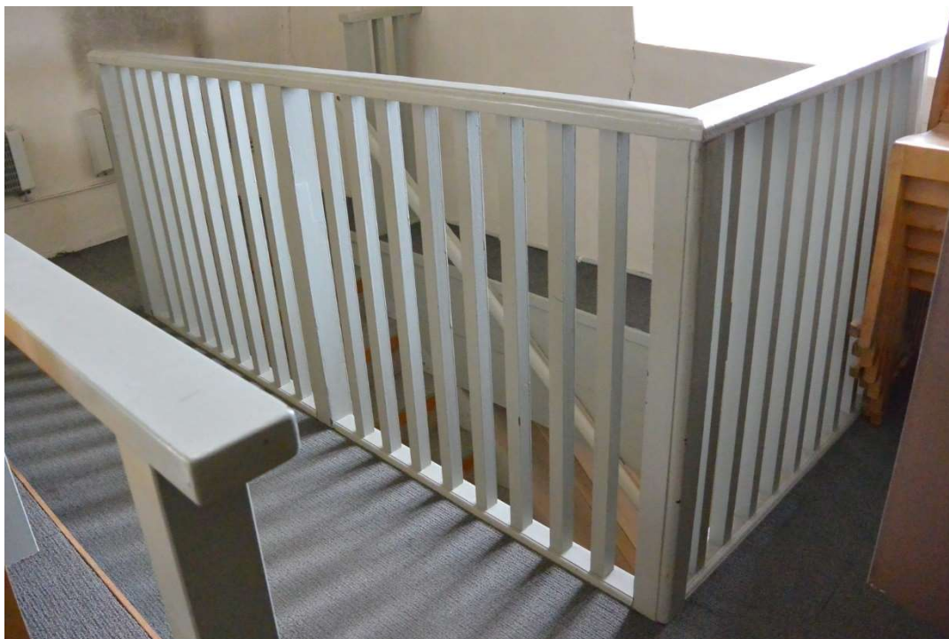
Fig. 41. Den södra läktartrappan före arbetet.
