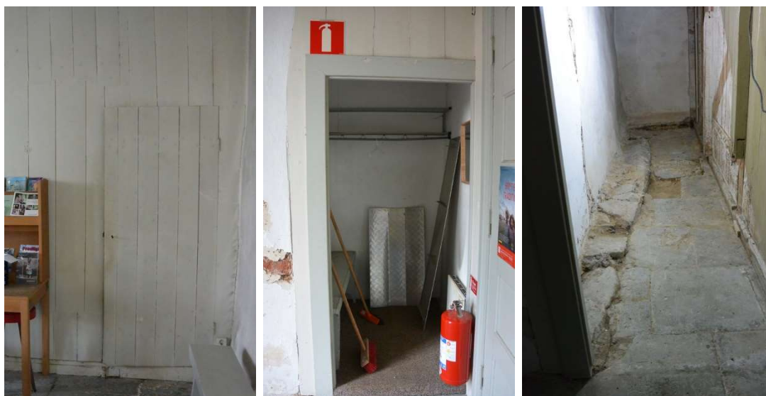
Fig. 11. Den norra förrådsdörren, före arbetet. Fig. 12. Kapprummet sett från vapenhuset, före arbetet. Fig. 13. Under en sentida betonggjutning fanns kalkstensplattor och en utskjutande sockel av natursten utmed insidan av västra yttermuren.
