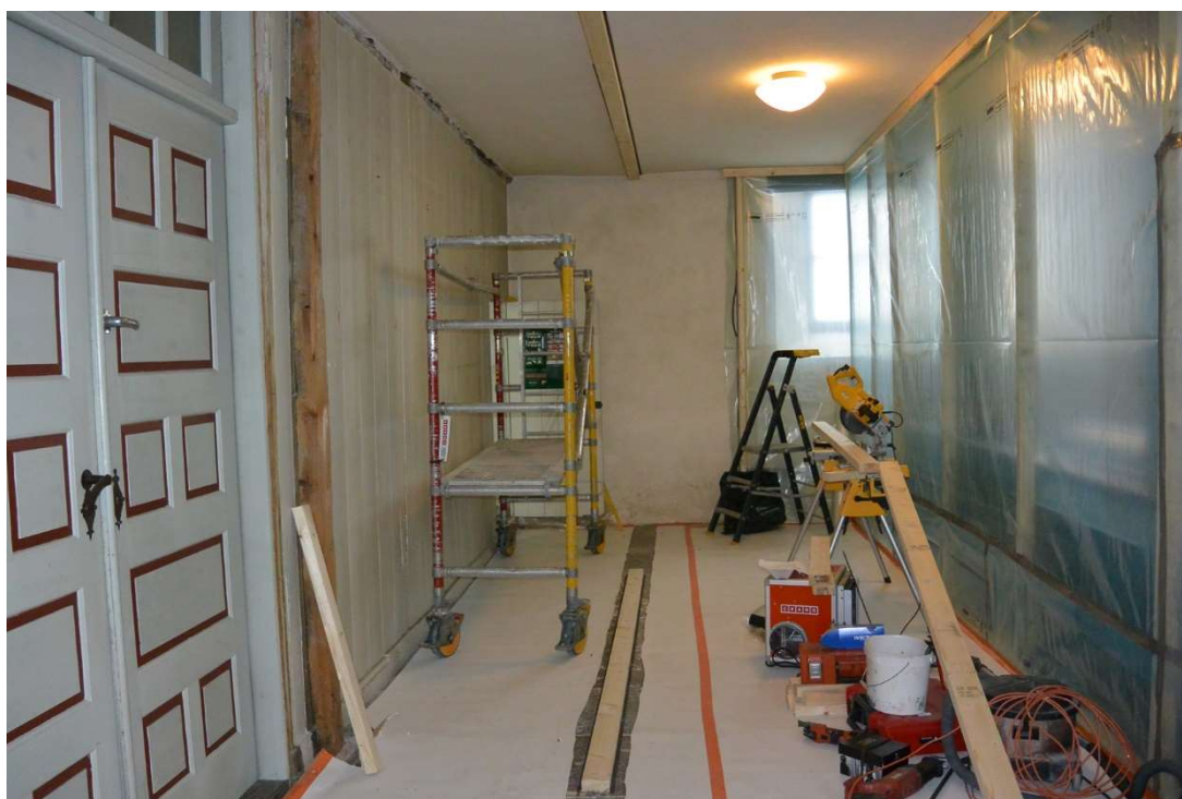
Fig. 14. Demontering av lister och panel har påbörjats. Den nya väggens fästen i tak och golv är på plats.
