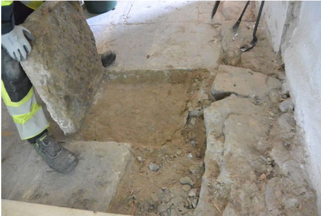
Fig. 25. Kalkstensplattor lyfts bort i utrymme för RWC.
