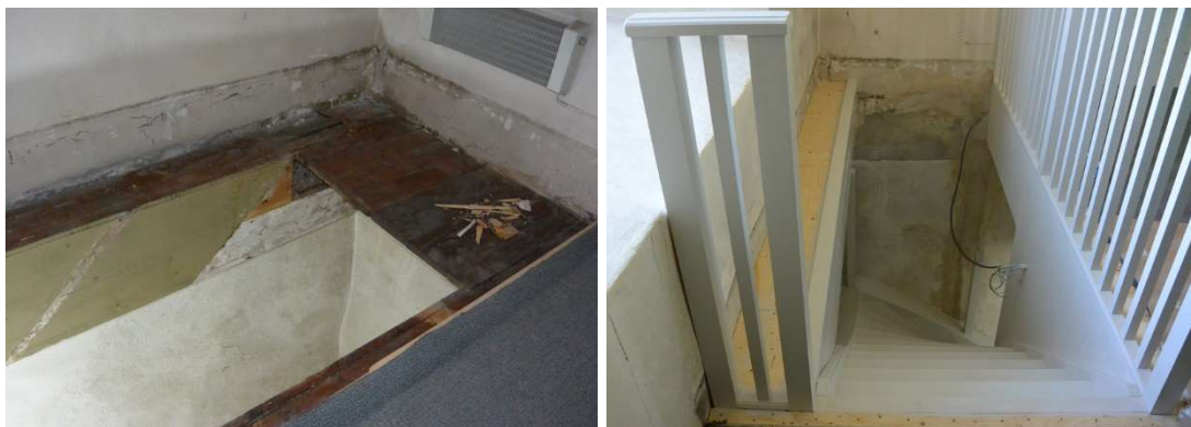
Fig. 22. Öppnat trappschakt. Fig. 23. Den nya trappan.
