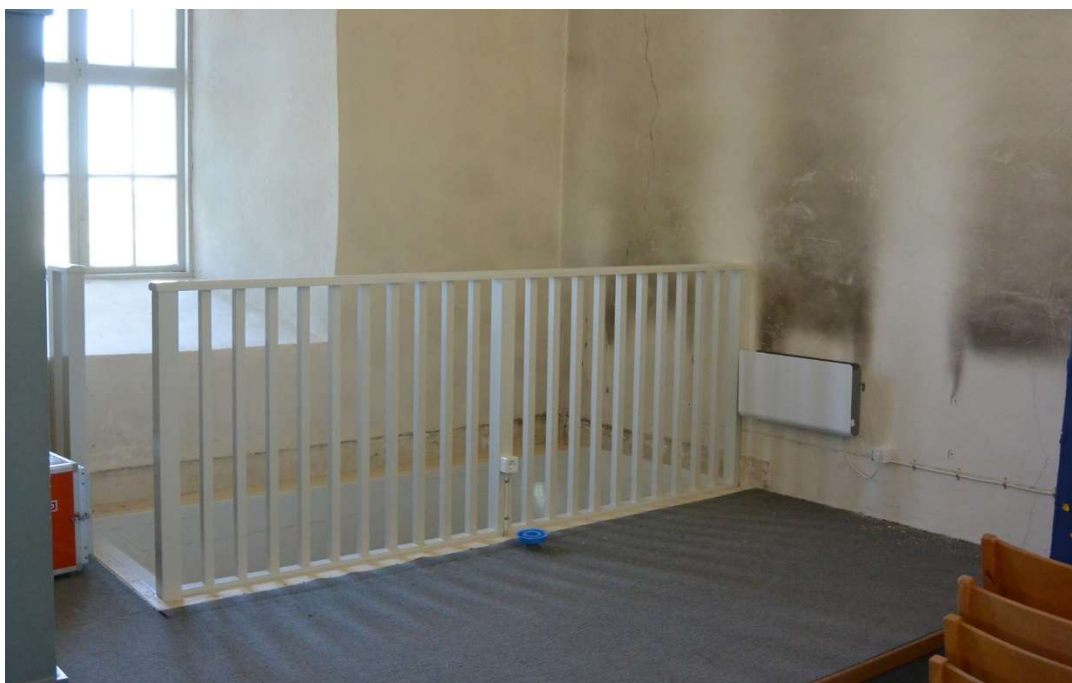
Fig. 24. Nyttillverkat räcke kring trappan.
