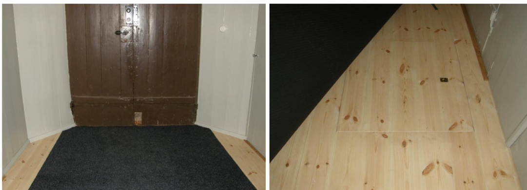
Fig. 15. Vapenhusets golv efter ombyggnad, vy mot entrédörr. Fig. 16. Nyttillverkad inspektionslucka.
