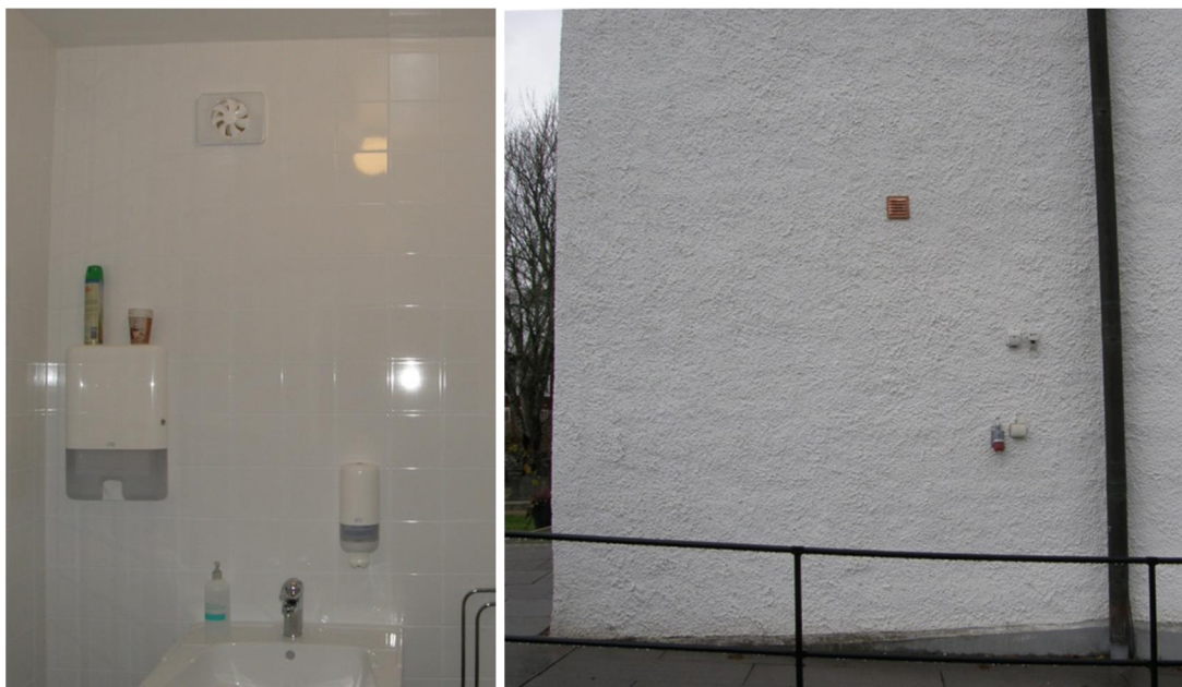
Fig. 17. På insidan monterades en fuktstyrd pax-fläkt. Fig. 18. På utsidan sattes en lamellventil av koppar.
