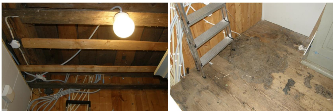
Fig. 5. Synligt träbjälklag innan ombyggnad. Fig. 6. Äldre brädgolv i förrådsutrymme.
