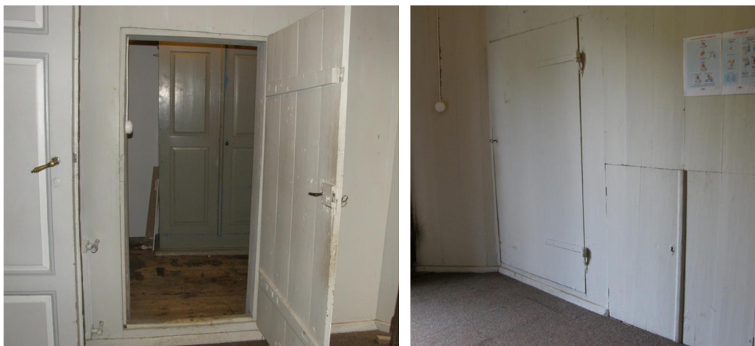
Fig. 3. Förrådsutrymme i anslutning till vapenhusets östra sida, innan ombyggnad. Fig. 4. Vapenhusets västra sida med släta enkla brädväggar, dörr mot trapphus samt lucka till teknikutrymme.
