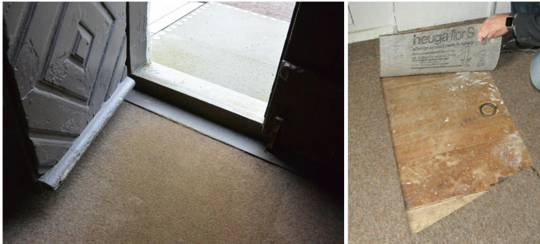
Fig. 11. Entrédörr och nivåskillnad innan ombyggnad. Fig. 12. Äldre inspektionslucka under nålfiltsmattan.
