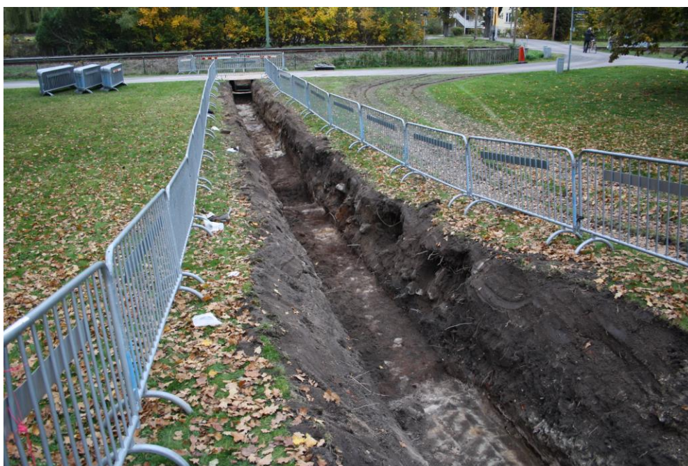
Fig. 10: Den yttre vallgraven framträdde som en bred, mörk nedgrävning i ledningsschaktets västra del. Foto från öster.
