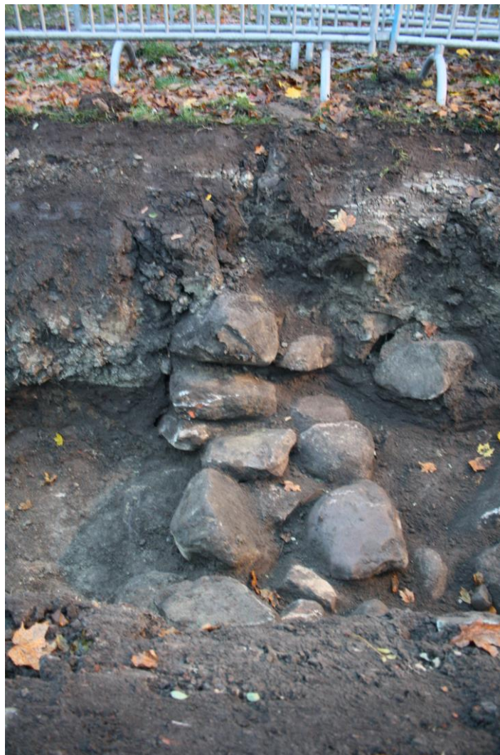
Fig. 16: Den västra källarmuren A226 efter framrensning. Foto från söder.
