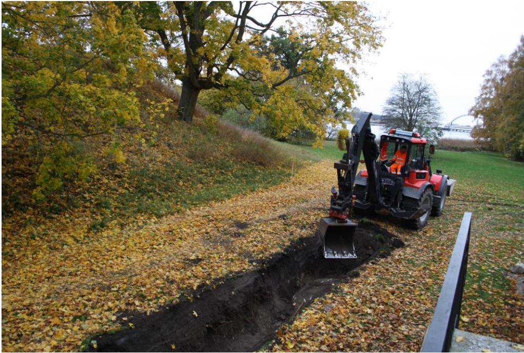
Fig. 17: Schaktning i den inre vallgraven. Foto från norr.
