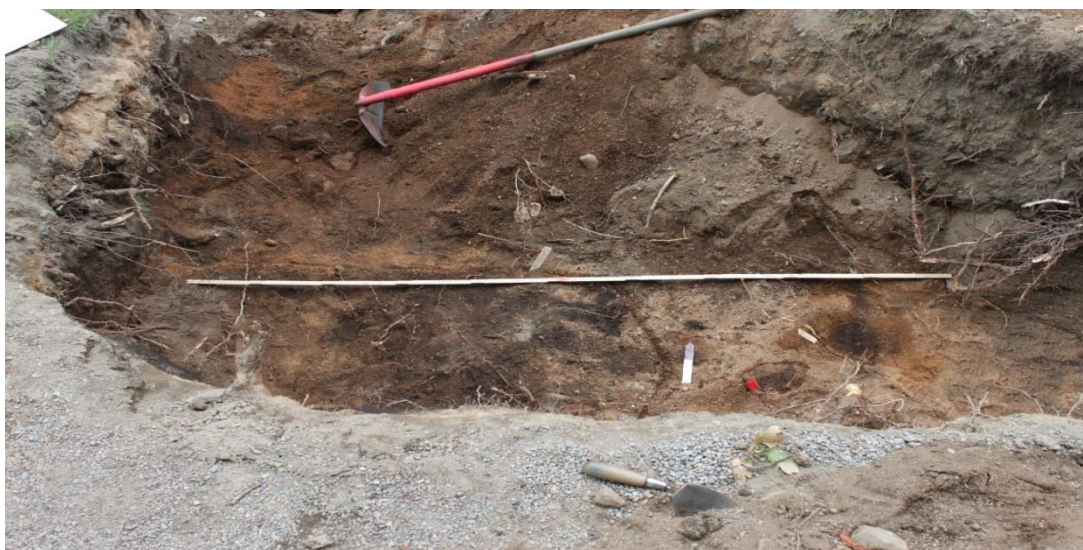
Fig. 7 Grop samt eventuella stolphålsfärgningar i schakt för septiktank
