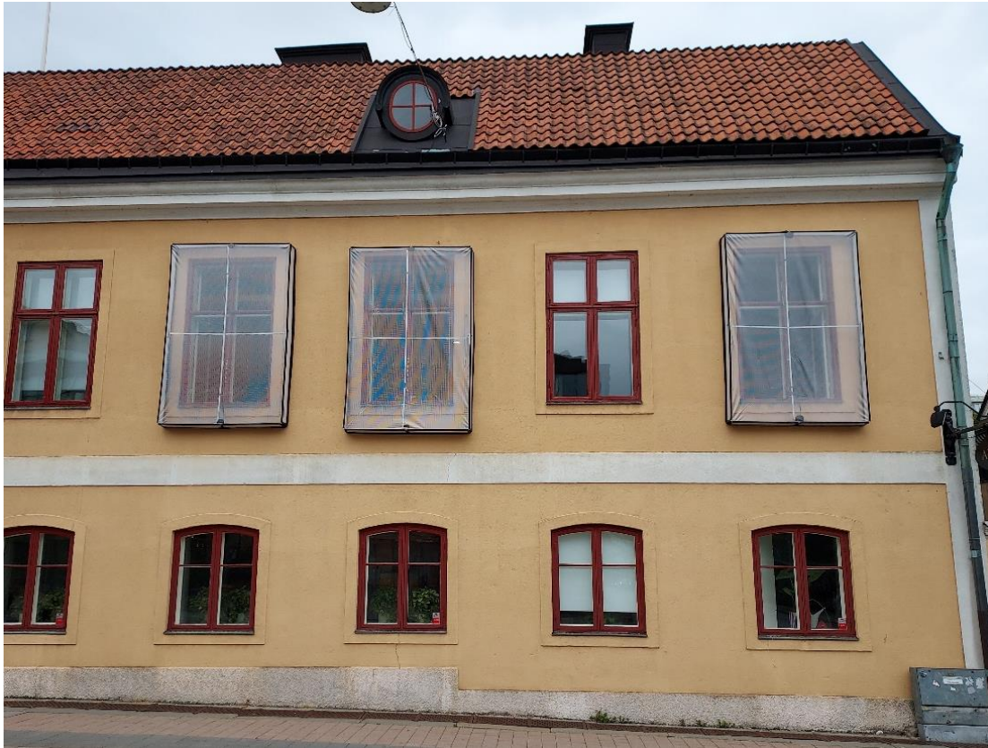
Fig. 8. Vy mot östra fasaden, under arbetet.
