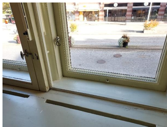
Fig. 6. Slutmålad karm och ytterbåge.
