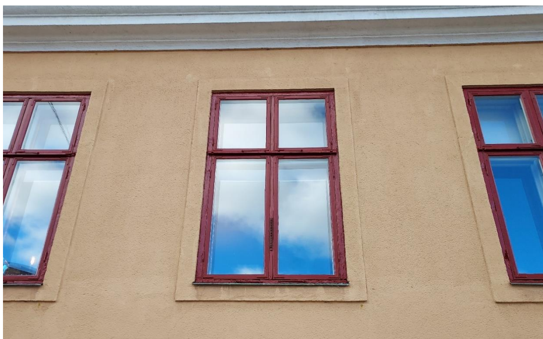
Fig. 7. Tre av fönstren, efter arbetet.
