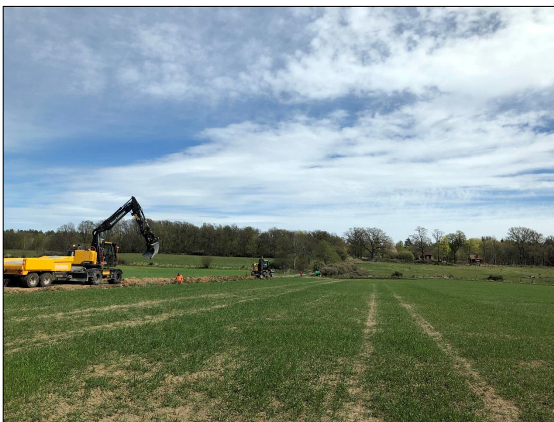
Fig.2 – Pågående schaktning mot Äsketorp. Fotografi mot SO.
