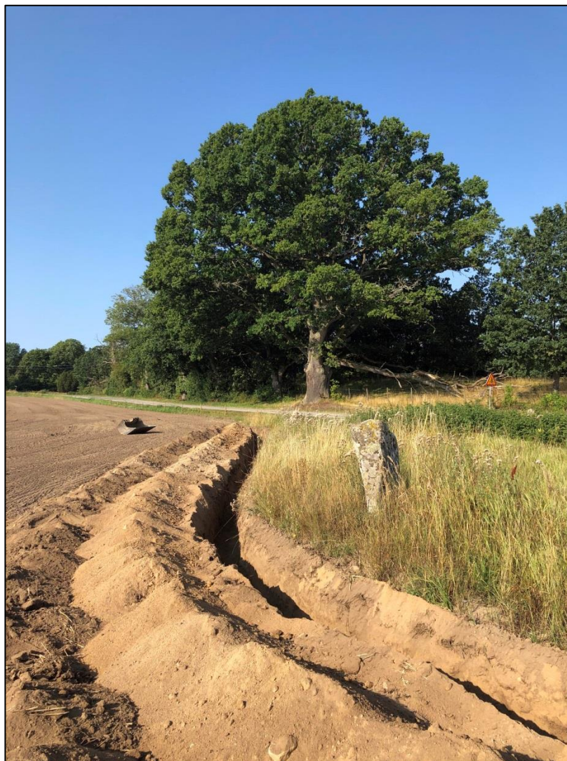
Fig.3 – Ledningsschakt vid RAÄ Hjortsberga 32:1-3.. Fotografi mot SO.
