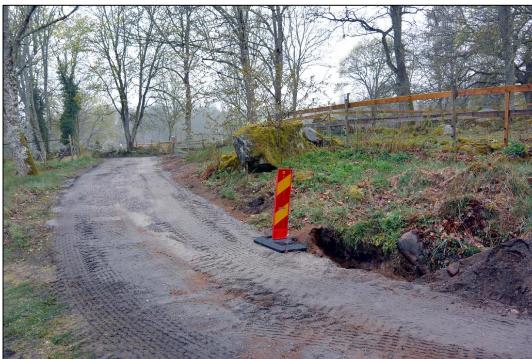
Fig.6 – Skärningen av vägen med sektionen för L2021:14 ännu exponerad. Fotografi mot S.
