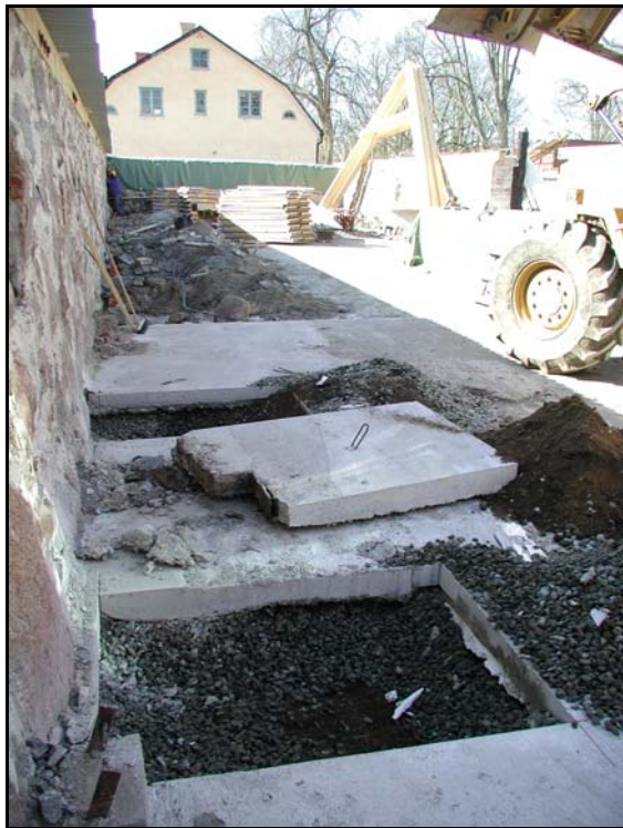
Fig.6 – Genombruten betongplatta i östra längans norra del.
