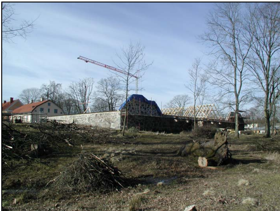
Fig.3 – Överblick slottslängorna under återuppbyggnad, fotograferade mot sydväst.
