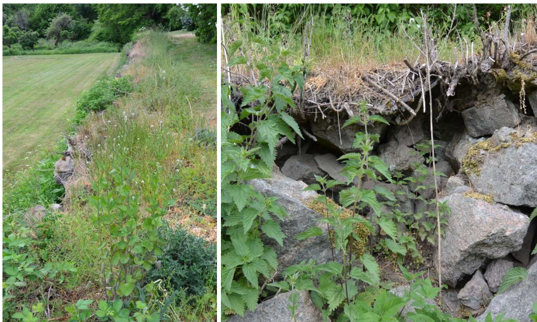
Fig. 8. Ovansidan av muren före arbetet, vy mot söder. Fig. 9. Raserat parti där murens fyllning bestående av mindre stenskravel blottas.
