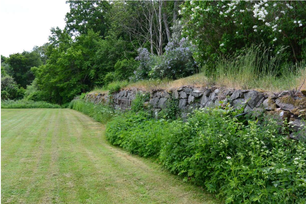
Fig. 7. Stödmuren före arbetet, vy mot söder.
