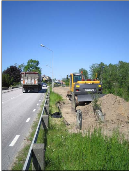
Fig.3 – Pågående utgrävning vid Ekespjället, Mörrum 2007
