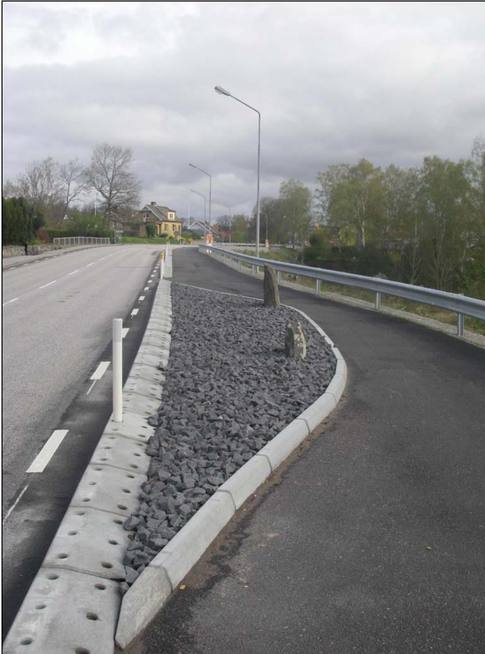
Fig.5 – Färdigställd GC-väg vid Ekespjället, Mörrum 2008-05-02
